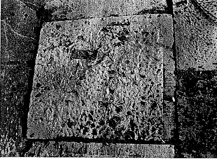
1. Üst döşeme 4 no lu blok
