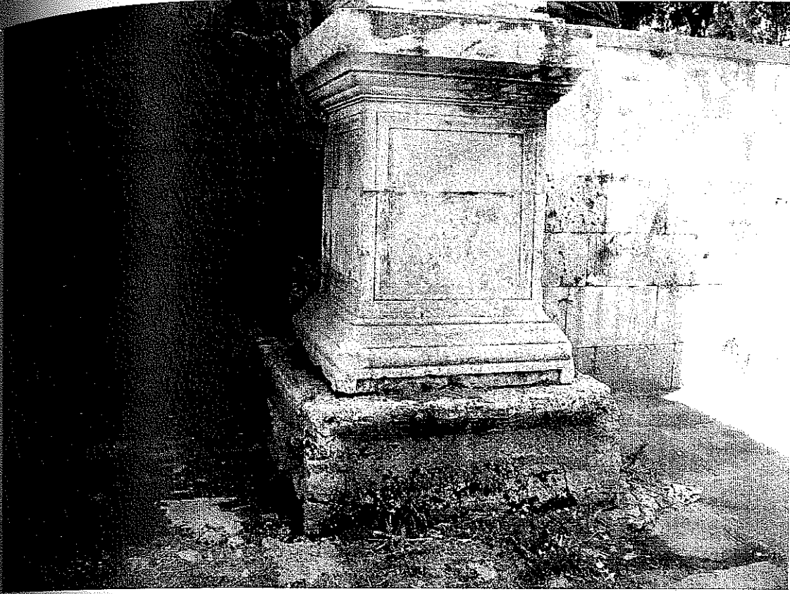
1. Kuzeydoğu köşe yarı yüksekliğe kadar orijinal postament
