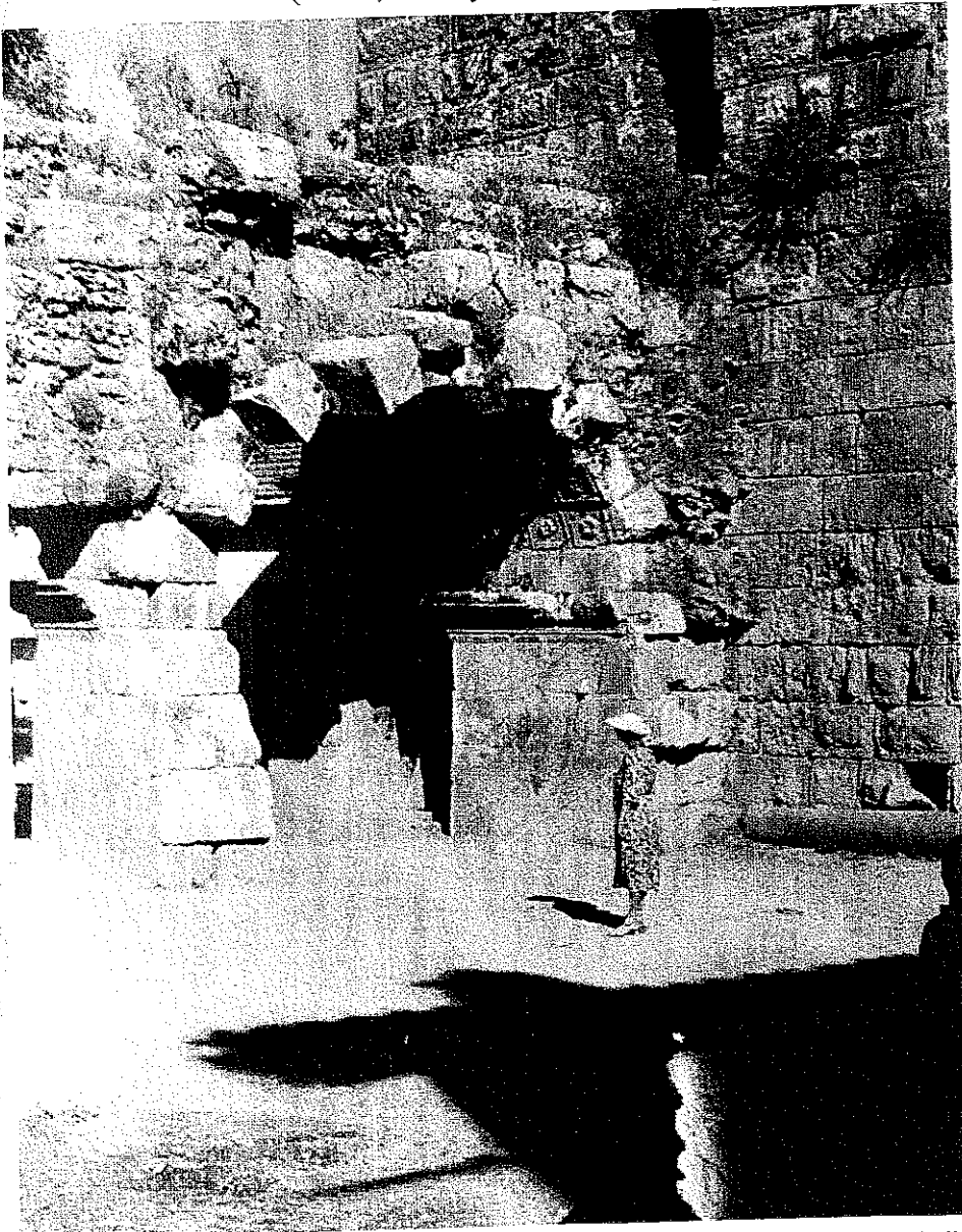
2. Restorasyon öncesi III. tonoz batı cephesi devşirme blokların görünüşü (AKMED KP I-II 308)
