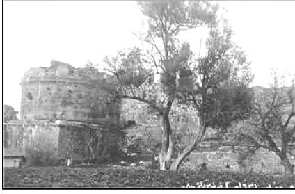
2. Hıdırlık Kulesi. Güneyden Görünüş 1915 civarı
