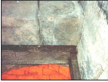
2. Ana Mekana Giriş Kapısı. Lento ve Demir Konstrüksiyon. Detay
