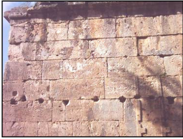
3. Kuzeydoğu Cephe. Hatıl Yuvaları
