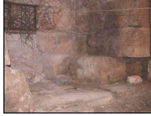
1. Ana Mekan. Güneybatı Niş. Tahrip Edilmiş Zemin
