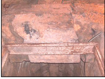
1. Ana Mekana Giriş Kapısı. Lento ve Demir Konstrüksiyon
