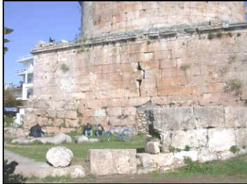
3. Güneybatı Cephe. Detay
