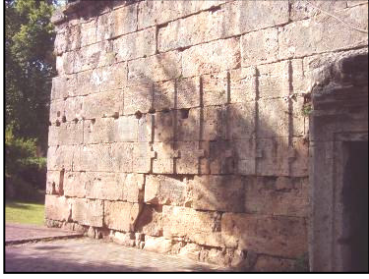
2. Kuzeydoğu Cephe. Fascesler. Sol
