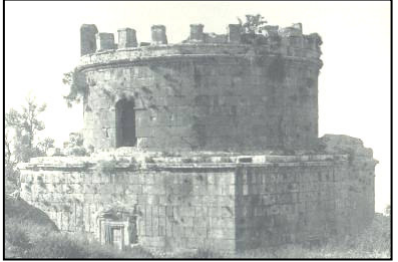
3. Hıdırlık Kulesi. Kuzeyden Görünüş 1936
