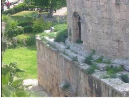
1. Ana Cephe. İkinci Kata Giriş
