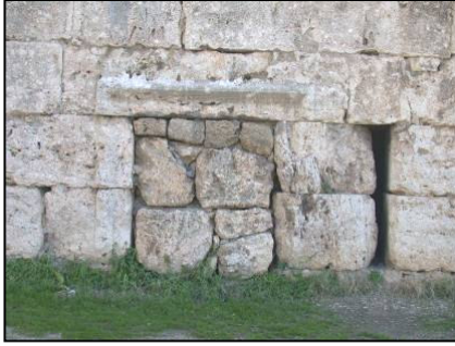
2. Kuzeybatı Cephe. Detay. Doldurulan Kapı ve Mazgal Açıklığı
