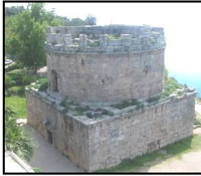
2. Hıdırlık Kulesi. Kuzeyden Görünüş
