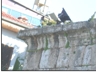
2. Kaide Saçak Silmesi. Detay
