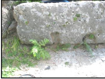
3. Üst Kat İçi. Devşirme Bloklarda Kenet, Dübel ve Kaldırma Yuvaları
