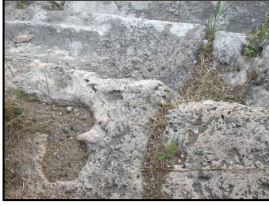
1. Üst Kat Giriş Eşiği. Ahşap Söve ve Mil Yuvaları
