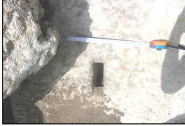
2. Üst Kat İçi. Devşirme Bloklarda Kenet, Dübel ve Kaldırma Yuvaları
