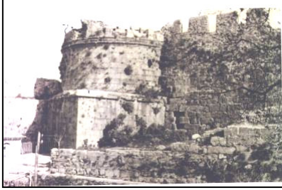
2. Hıdırlık Kulesi. Güneyden Görünüş 1910 civarı
