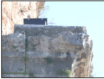
3. Kaide Saçak Silmesi. Detay
