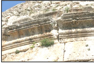
3. Üst Yapı Saçak Silmesi. Detay
