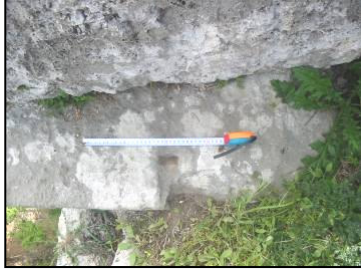
1. Üst Kat İçi. Devşirme Bloklarda Kenet, Dübel ve Kaldırma Yuvaları
