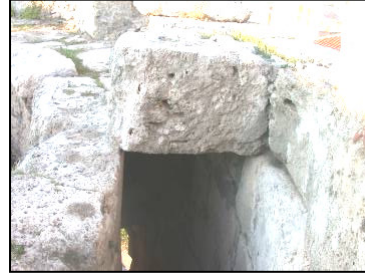
2. Üst Kat Örtü Blokları. Dıştan Görünüm
