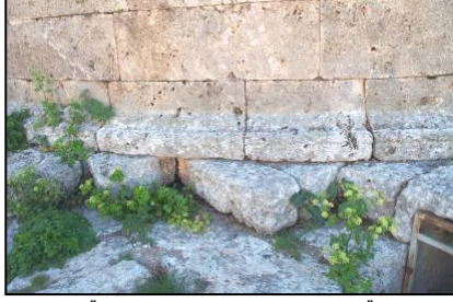
2. Kaide Üstü. Kuzey Köşe. Eksik Bloklar ve Üst Yapı Toichobati
