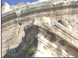
1. Kaide ve Üst Yapı Saçak Silmesi
