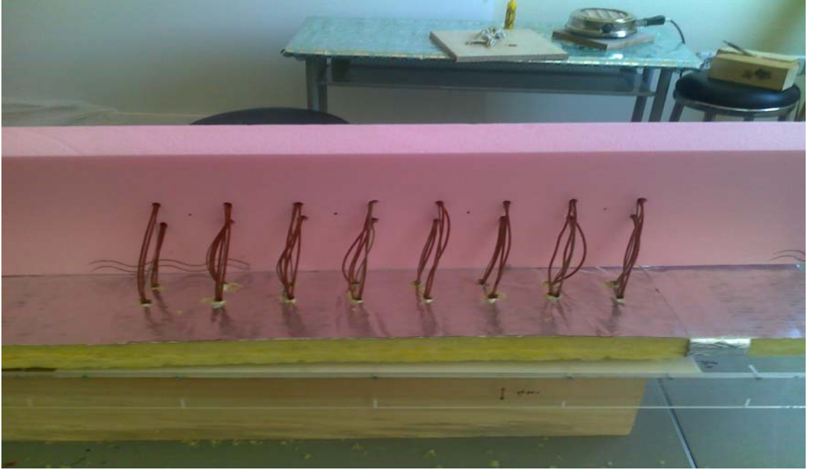
Şekil 3.7. Foamboard (XPS) yalıtım malzemesinin montajı
