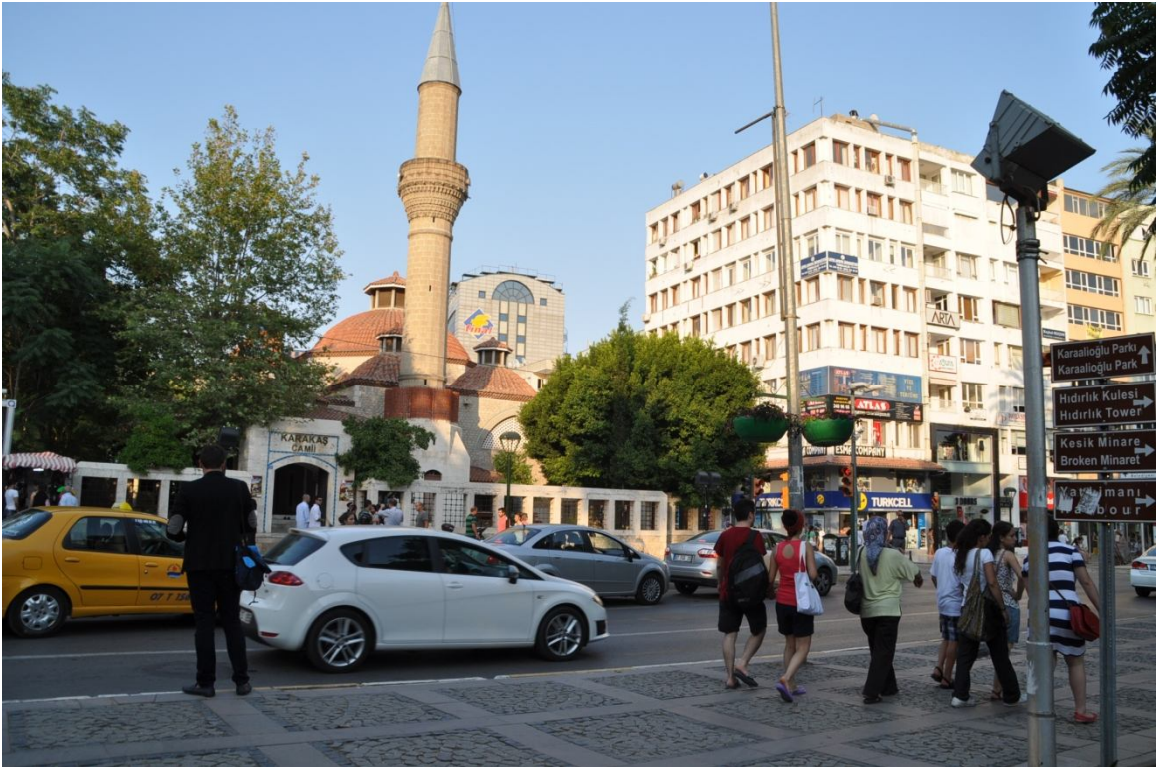
Fotoğraf 26- Üç Kapılar Karşısında Bulunan ve Restore Edilen Karakaş Camii.
