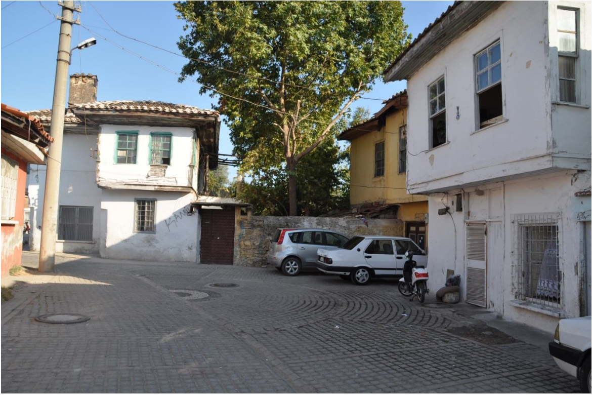
Fotoğraf 45- Bakımı Yapılmamış Ahşap Evler.
