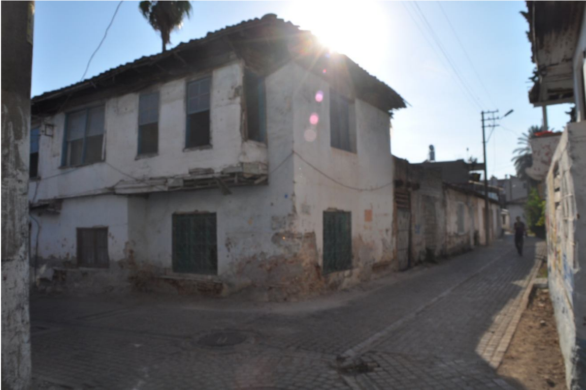
Fotoğraf 46- Kullanılmayan Bakımsız Bir Ahşap Ev ve Sokaklar.
