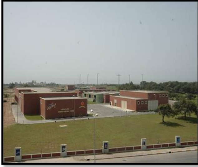
Şekil 3.1. Lara ileri atıksu arıtma tesisinin genel görünümü
