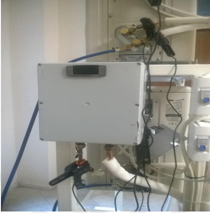
Şekil 3.6. Klima Sistemine İlave Edilen Isıtıcı Ünite
