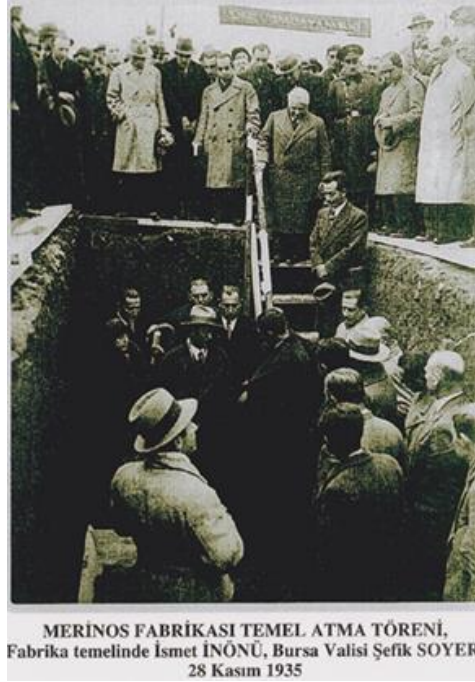
Fotoğraf-1 Merinos Fabrikası Temel Atma Töreni, 28 Kasım 1935.
