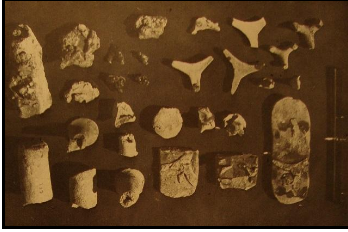
Resim 59. Fırın İçi Destek Parçaları (Karamağralı 1987 s.484, Fig.4.).
