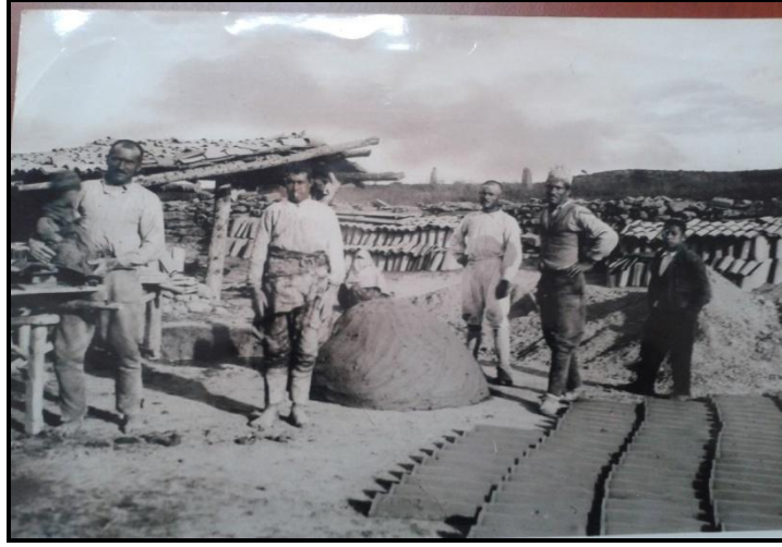
Resim 102. Sırören’de Kapama Kiremit Yapan İşçiler.
