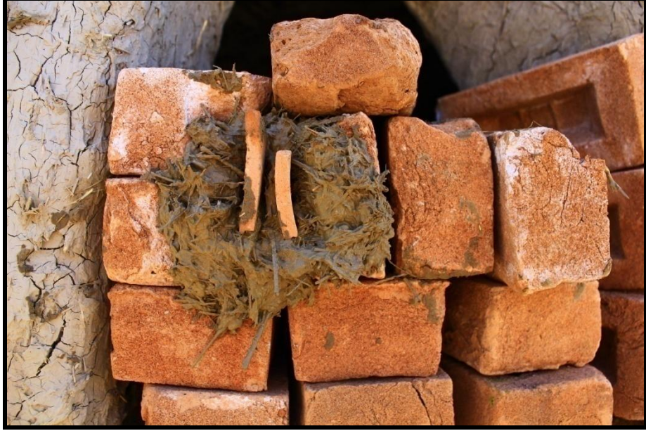
Resim 48. Fırın Sıva Uygulaması.
