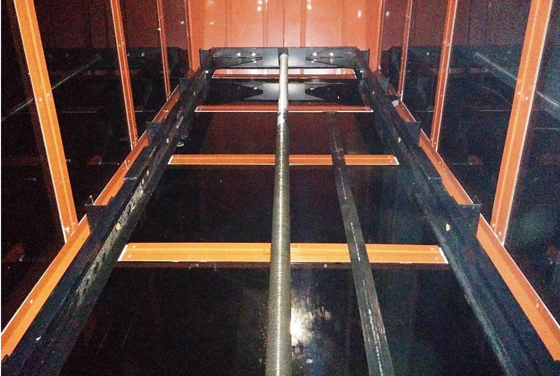
Şekil 2.19. Konsollar, raylar, vidalı mil ve bükülgen kablo ile kuyu içi görünümü
