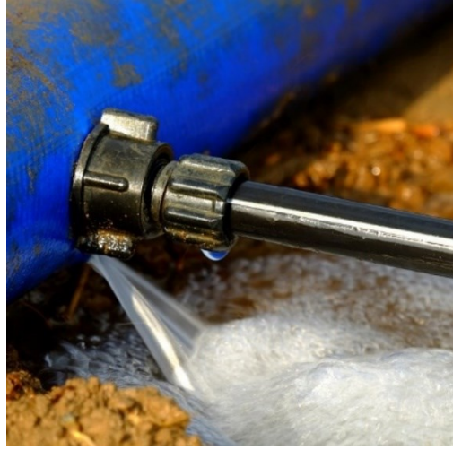
Şekil 2.4. Servis bağlantıları ile abone arasında meydana gelen kayıplar (Anonim – 4, Anonim – 5)
