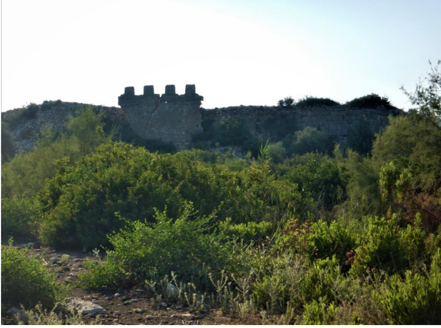
Şekil 4.14. Patara sur duvarında yer alan muhtemelen deprem nedenli çatlak.
