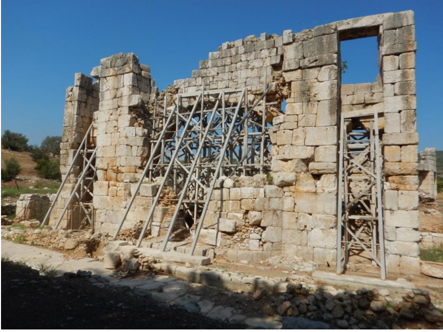
Şekil 4.18. Patara'da yer alan ve restore edilmekte olan bir yapı.
