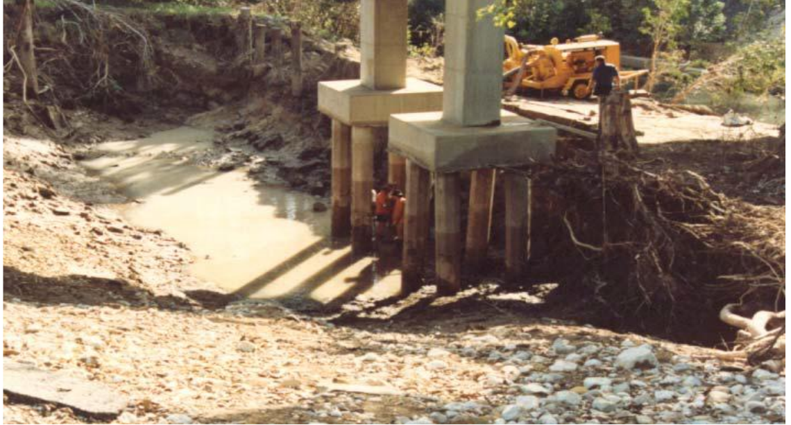
Şekil 2.1. Logan nehri üzerinde kazık yerel oyulma hasarı (Lança vd. 2013)
