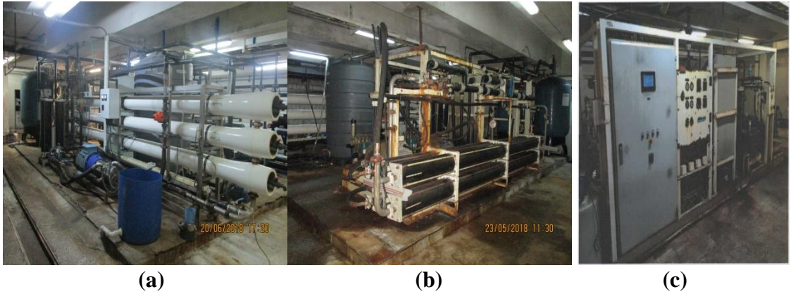
Şekil 3.9. a) WOW Bodrum TO prosesi 3 adet seri bağlı membran kılıfı; b) WOW Bodrum TO prosesi 4 adet seri bağlı membran kılıfı; c) WOW Bodrum TO prosesi kontrol paneli
