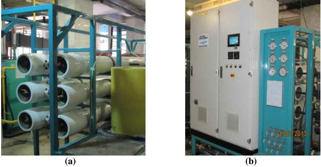
Şekil 3.8. a) TT Bodrum TO membran kılıfları; b) TT Bodrum TO kontrol paneli
