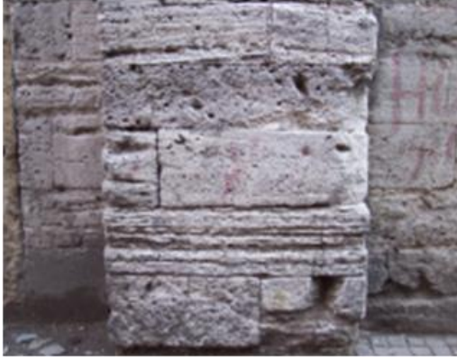
Şekil 3.13. Sıfır derz taş duvar
