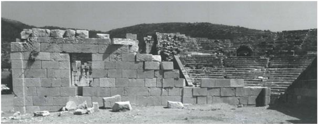
Şekil 4.9. Sahne yapısı batı cephesi dış görünüm
