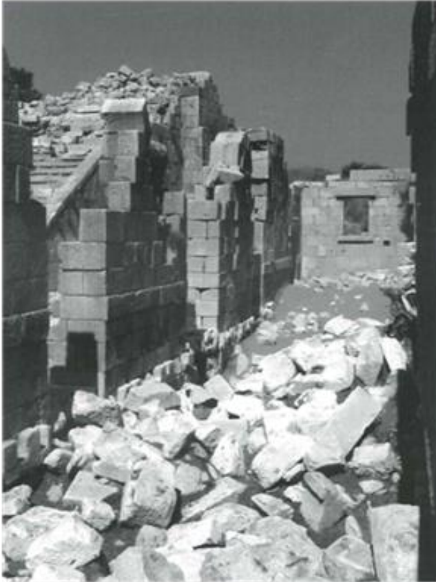
Şekil 4.6. Sahne yapısı güney cephesi iç görünüm
