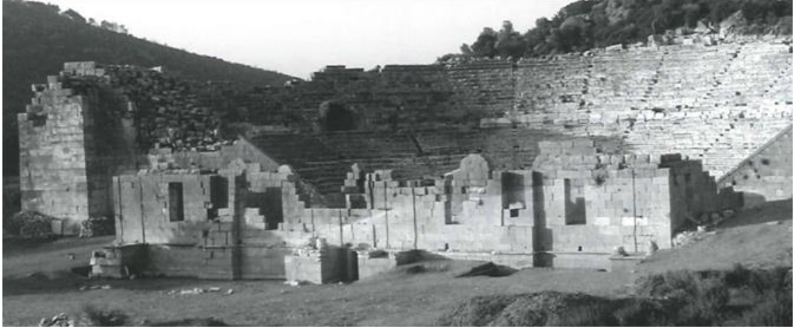
Şekil 4.7. Sahne yapısı kuzey cephesi dış görünüm
