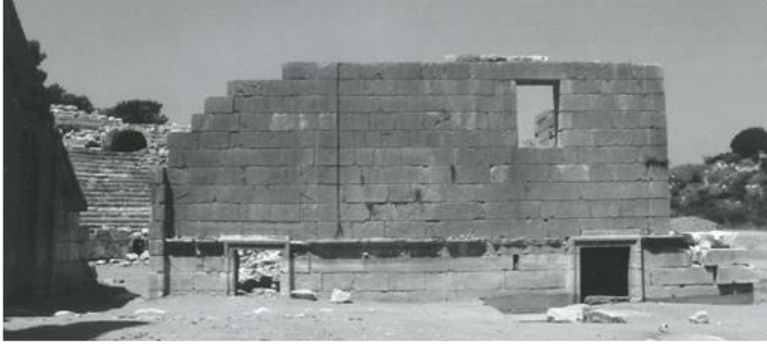
Şekil 4.11. Sahne yapısı doğu cephesi dış görünüm
