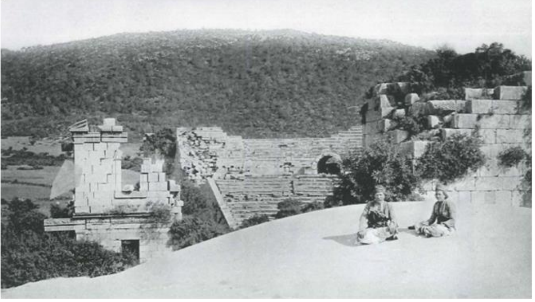
Şekil 3.4. Patara Antik Tiyatrosu 1881 yılı batı cephesinden görünüm (Benndorf ve Niemann 1884)
