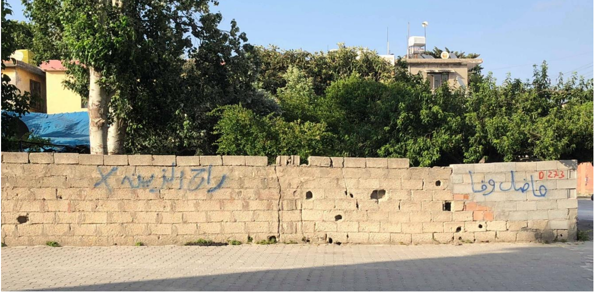
Fotoğraf 1 Emek Mahallesi'nde üzerinde Arapça Yazılar Bulunan Bir Duvar (Hatay, Antakya)
