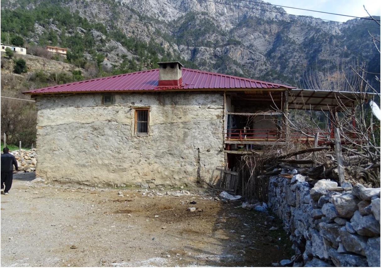
Fotoğraf 2.10 Alacami Mahaltesinde Geleneksel Taş Meskenler Üzerinde Modern Bir Çatı Örneği (17.02.2018)
