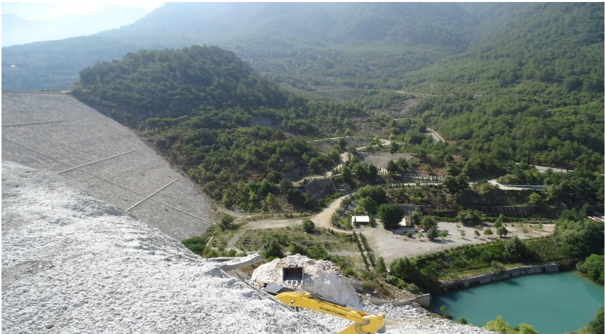
Fotoğraf 1.3 Dim Baraj Duvarı (16.08.2017)
