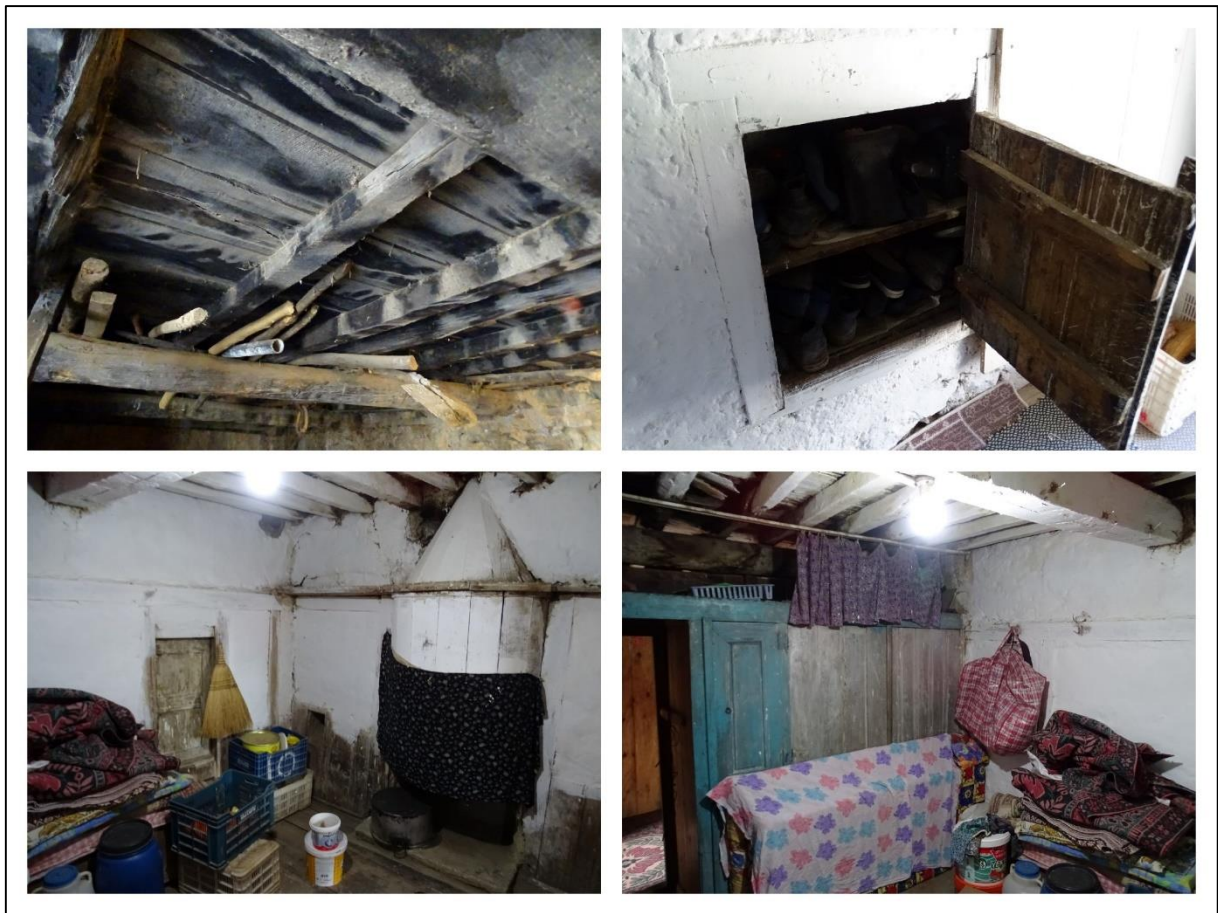
Fotoğraf 2.12 Taş Meskenlerde Kullanılan Ahşap Malzemeler (17.02.2018)
