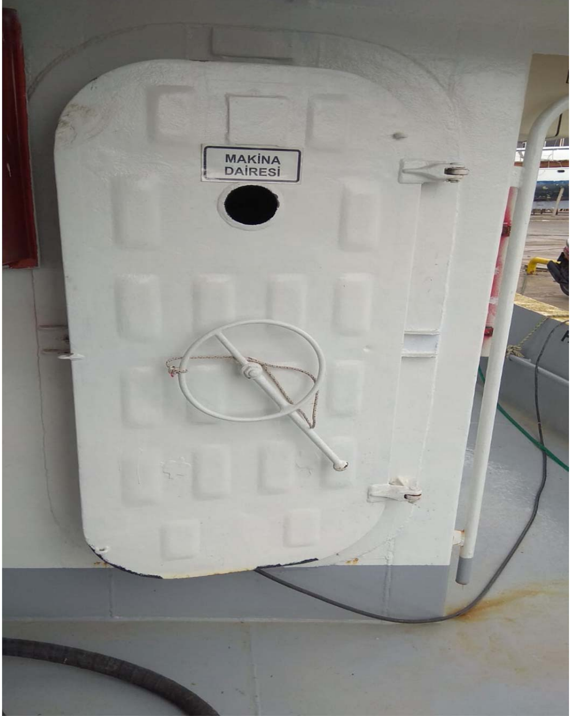
Şekil 4.15.1. Kapıların dıştan görünümü
