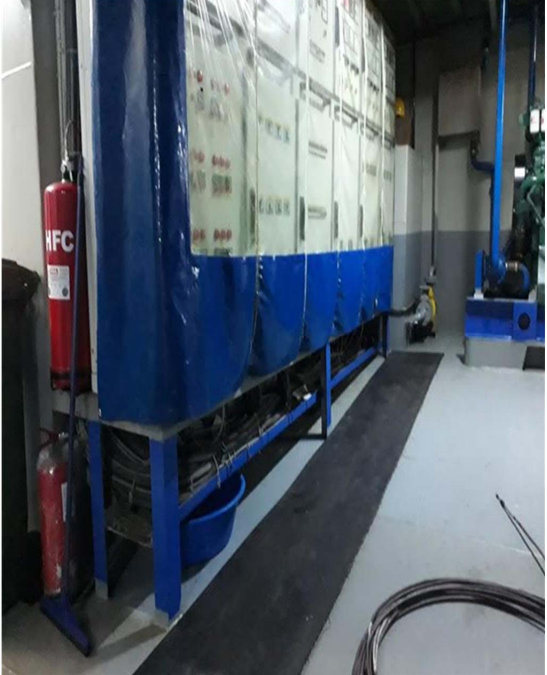
Şekil 4.7.1. Elektrik ana pano yerleşimi
