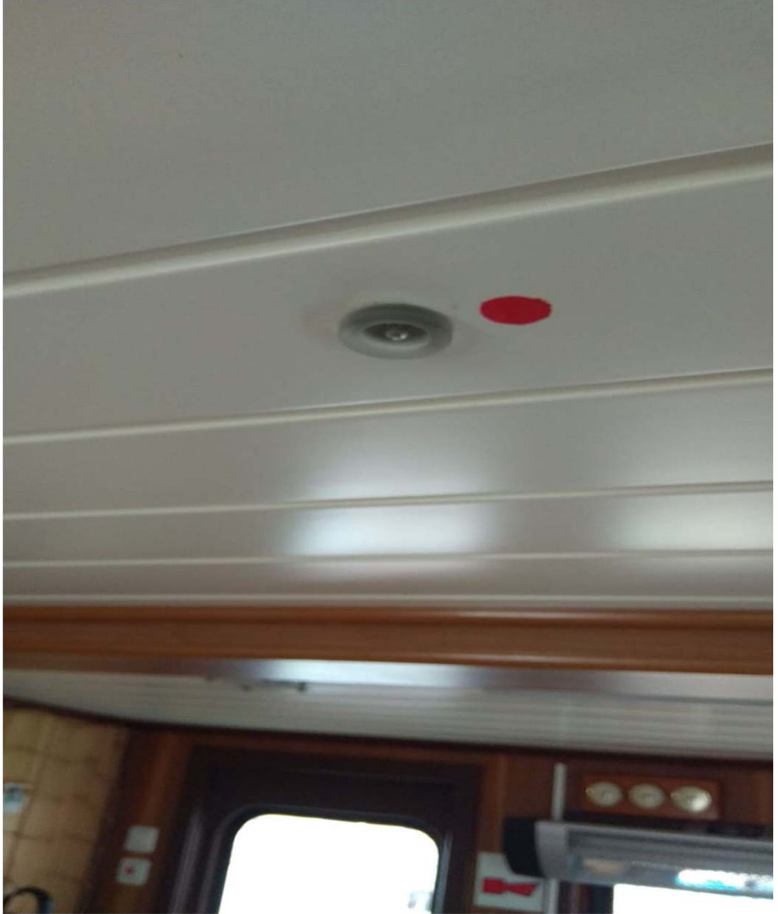
řekil 4.13.1. 24 volt enerji ile alıřan aydınlatma sistemi
