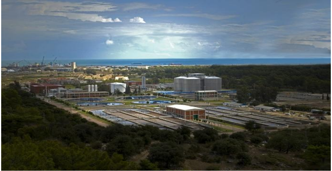
Şekil 3.1 Arıtma çamurunun temin edildiği Antalya Hurma Atık Su Arıtma Tesisi
