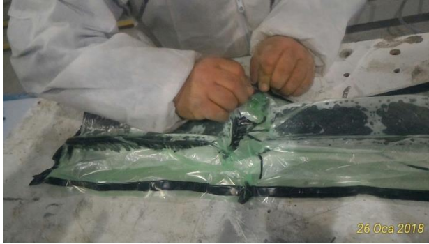
Şekil 3.7. Vakum uygulama işlemi
