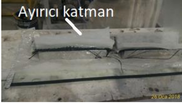
Şekil 3.6. Kalıplara karbon elyaf ve ayırıcı yerleşim işlemi
