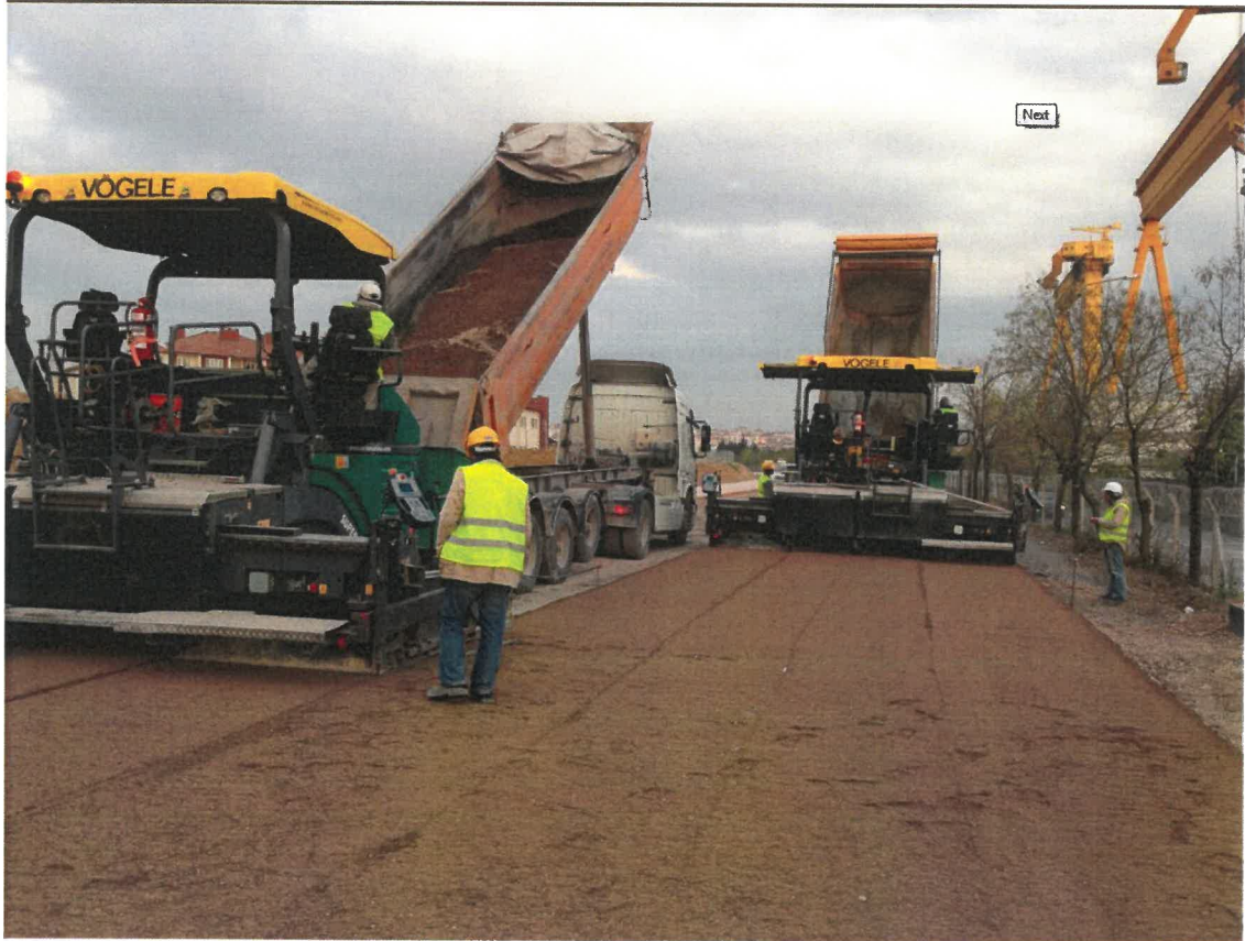
Şekil 2.3. Attemel yapım aşaması ( http://www.osmancamci.com.tr/faaliyetler/kara )
