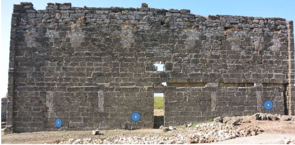
Şekil 3. 6. Çeşme yapısı arka cepheden alınan numunelerin yerleri
