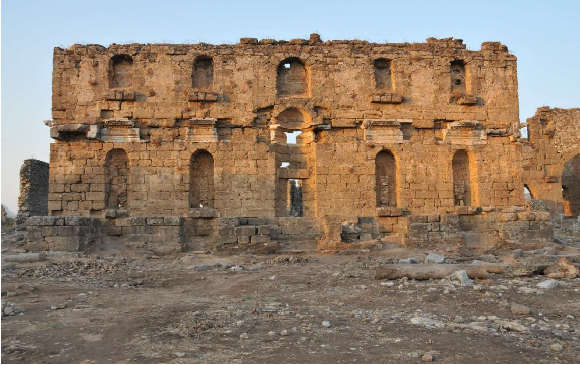
Şekil 3. 1. Çeşme Binası (Nymphaeum)
