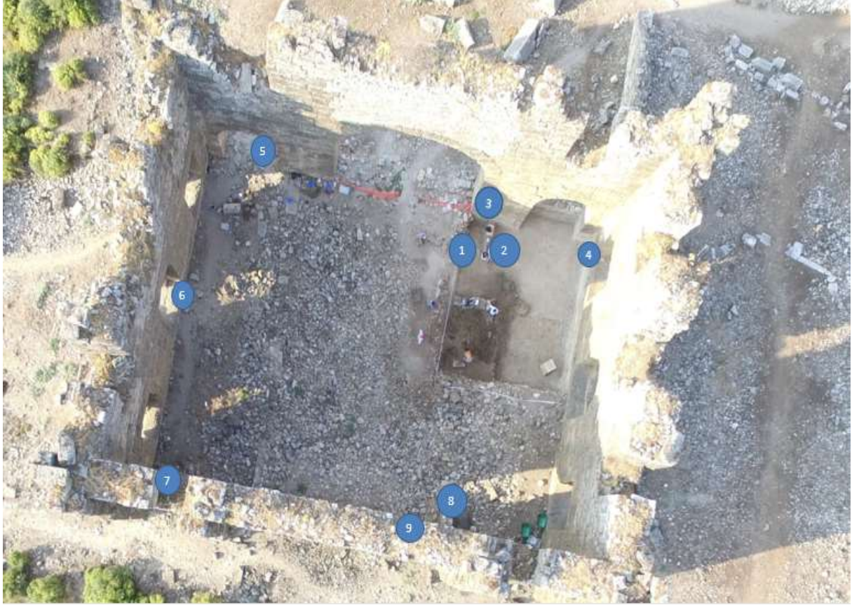
Şekil 3. 23. Bazilika yapısından alınan numunelerin yerleri
