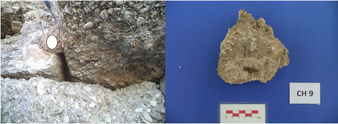
Őekil 3. 15. CH9 kodlu harç numunesi
