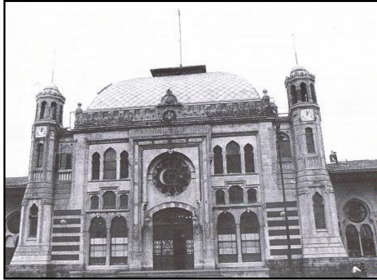
Şekil 2.43. Sirkeci Tren İstasyonu, Jachmund Tarafından İstanbul'da, 1890 Yılında İnşa Edilmiştir.
