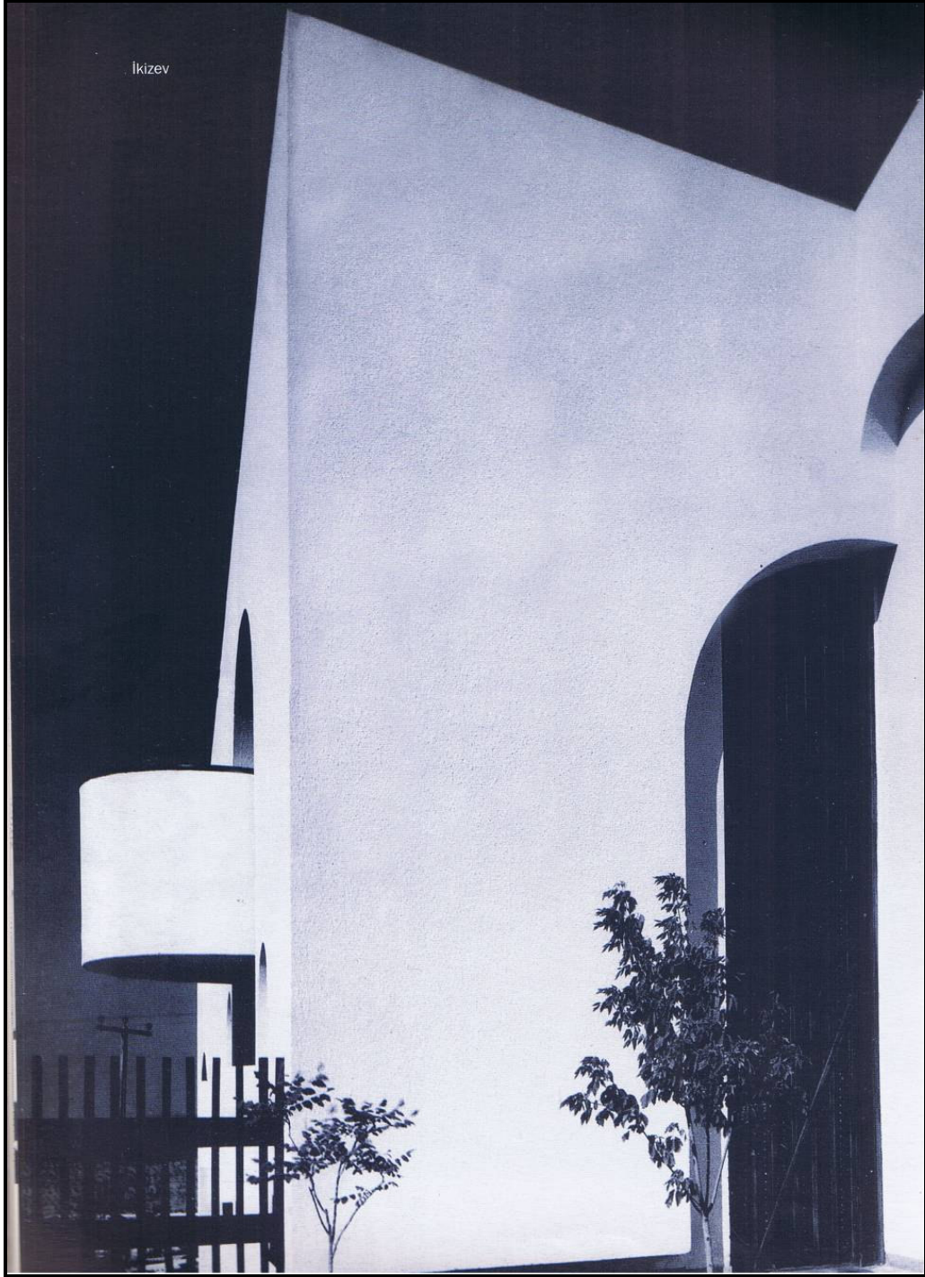
Şekil 4.35. İkiz Ev Giriş Kapısı
