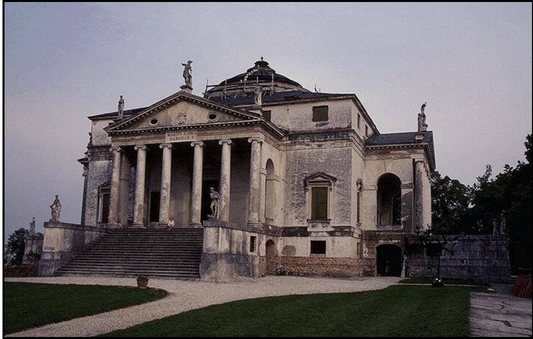
Şekil 2.35. Villa Rotondo, Palladio Tarafından, Vicenza, İtalya'da, 1566-1571 Yılları Arasında İnşa Edilmiştir.
