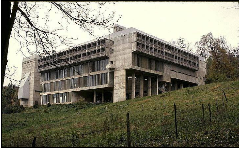
Şekil 3.12. La Tourette Manastırı, Le Corbusier Tarafından, Evieux-sur-Arbresle, Fransa'da, 1957- 1960 Yılları Arasında İnşa Edilmiştir.
