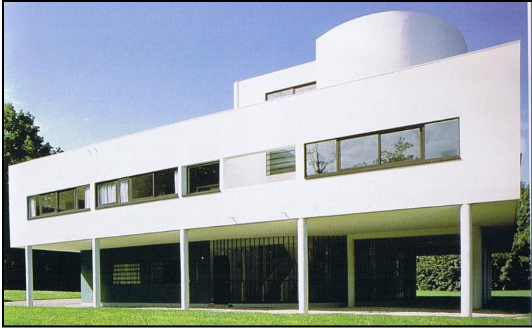
Şekil 2.36. Villa Savoye, Le Corbusier Tarafından, Poissy, Fransa'da, 1928-1929 Yılları Arasında İnşa Edilmiştir.
