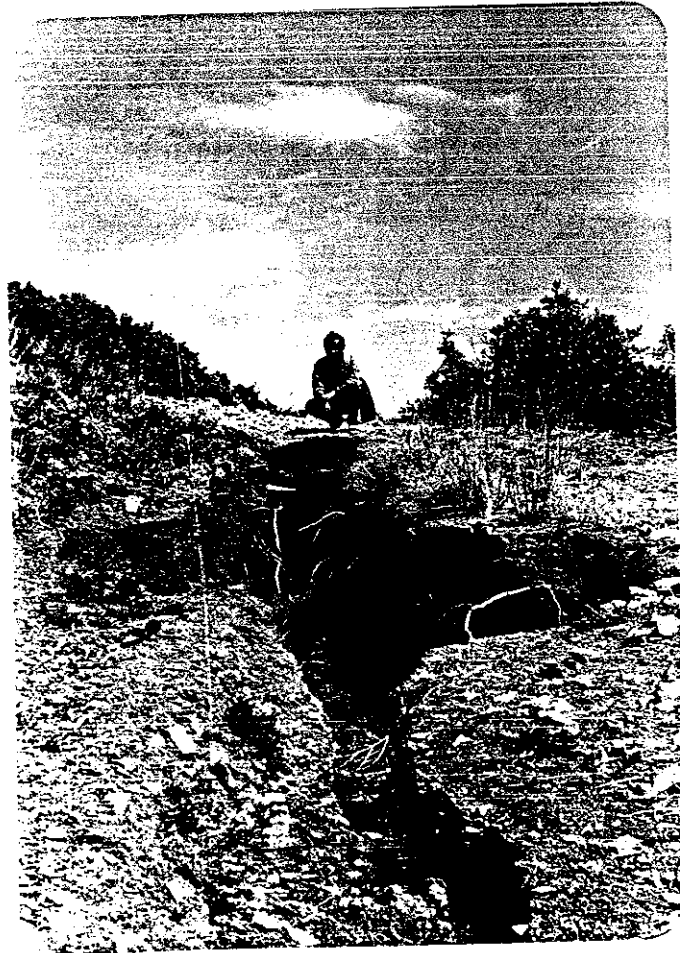
Foto 28- Üçüncü heyelan bölgesinde Temmuz 1987'de gözlenen tansiyon çatlağı.
