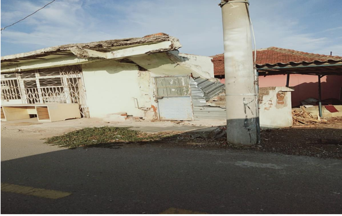
Fotoğraf 3. Güneş mahallesinde yıkımı devam eden bir gecekondu evine dair görsel (09.07.2020)
