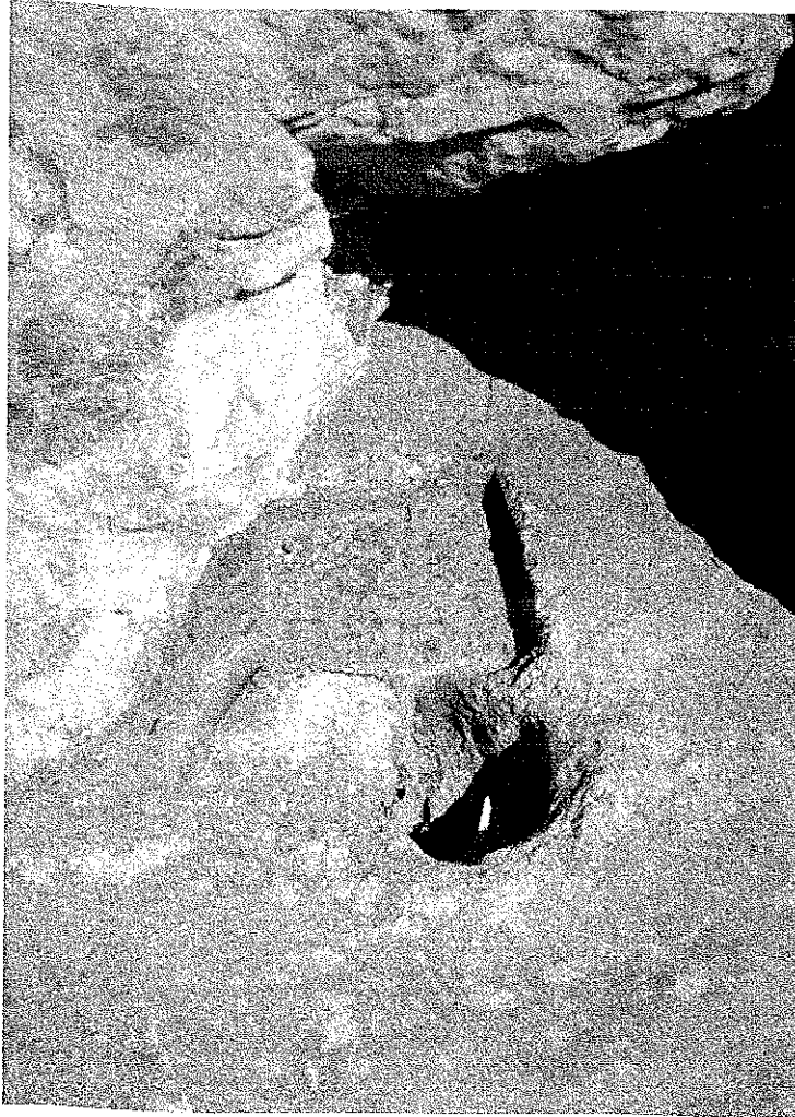
b. Akıtma kanallı dübel yuvası
