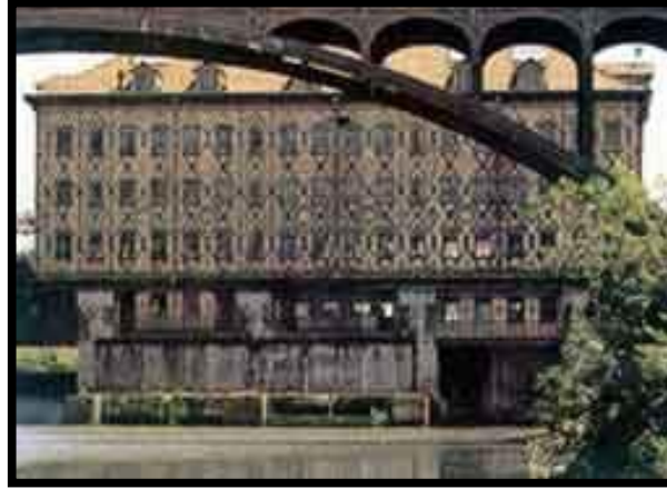
Resim 1.5. Galerie des Machines 1889
