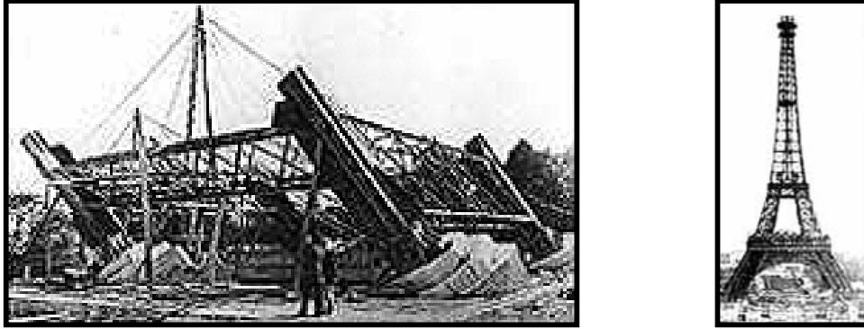
Resim 3.14 Eiffel Kulesi Yapım Aşaması, Eiffel Kulesi
