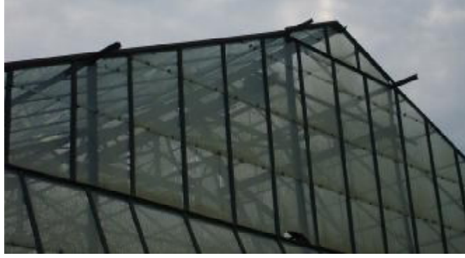
Şekil 4.4. İncelen Cam Seralarda Yaygın Olarak Kullanılan Aşık Profili
