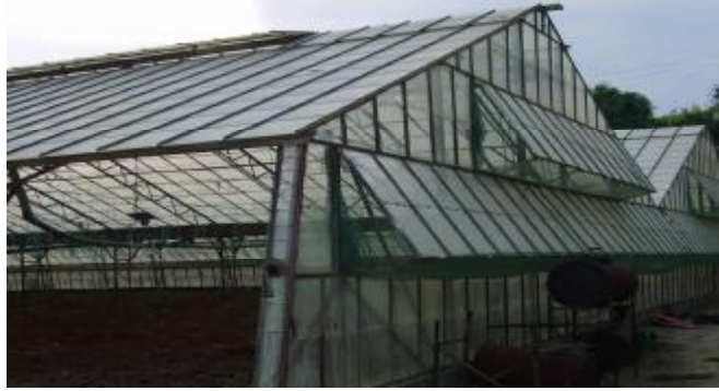
Şekil 4.5. İncelenen Cam Seralarda Yaygın Olarak Uygulanan Çatı Makası Tipi
