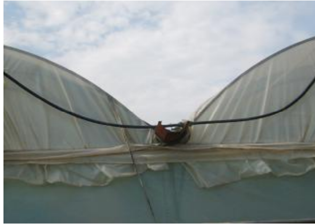
Şekil 4.6. Yay Çatılı Plastik Seralarda Kullanılan Metal Oluklar
