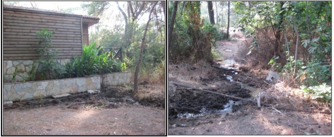
Şekil 3.6. Phaselis kentinde kullanılan tuvalet ve duş binasının atıksu tahliyesinden görünüm
