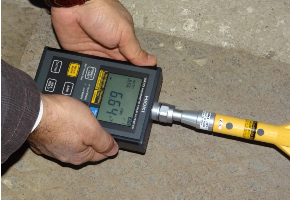
Şekil 5.2. Antalya ili Serik İlçesi Şehir 1 Fideri YG Kablo Kanalında Ekranlı Ölçüm
