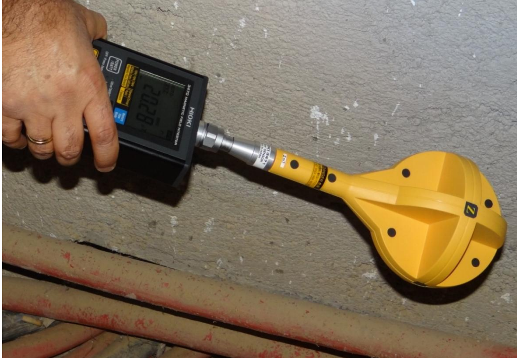
Şekil 5.1. Antalya ili Serik ilçesi Şehir 1 Fideri YG Kablo Kanalında Ekransız Ölçüm
