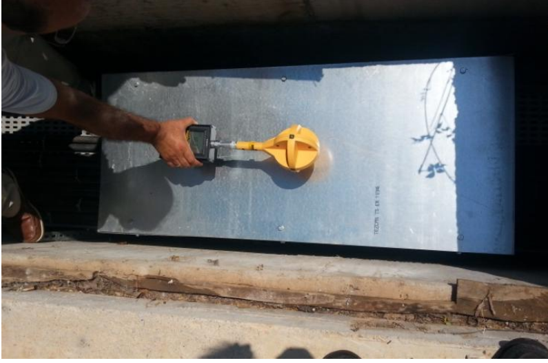
Şekil 3.16. Ters U Galvaniz Ekran ile AG Kanalda Ölçüm
