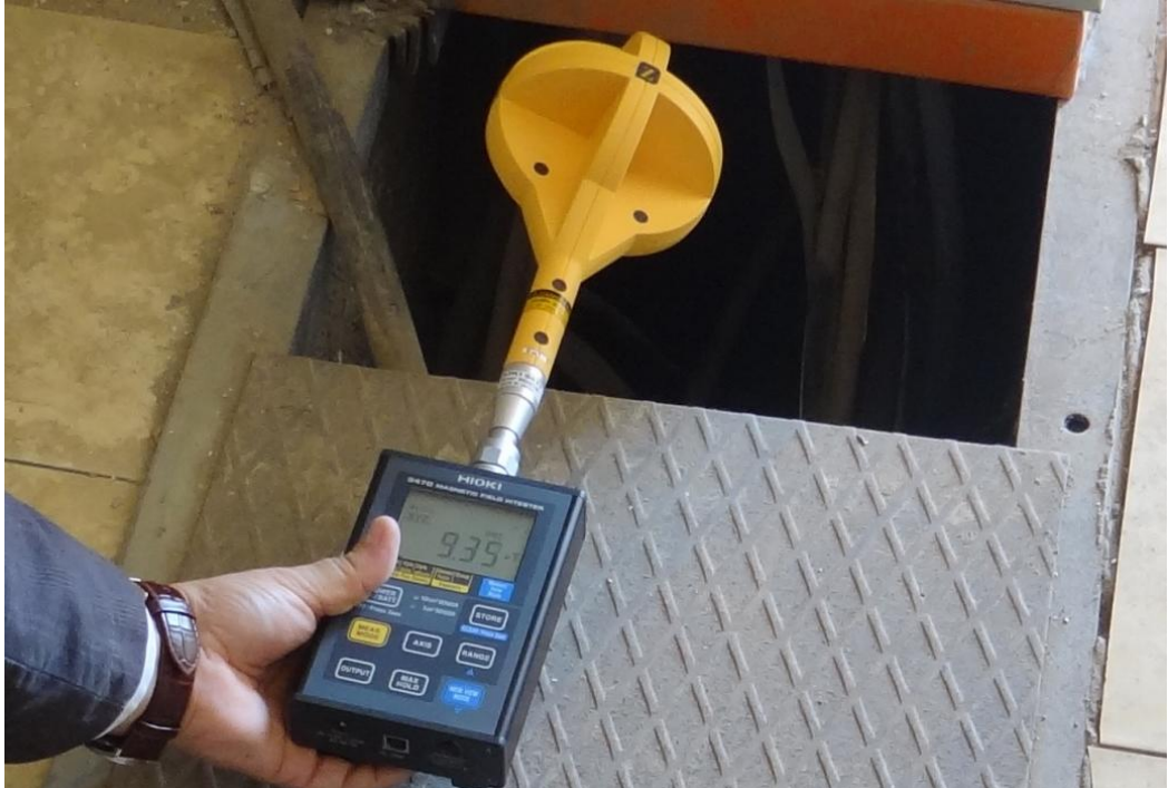
Şekil 5.3. Antalya ili Serik İlçesi Şehir 1 Fideri AG Kablo Kanalında Ekransız Ölçüm
