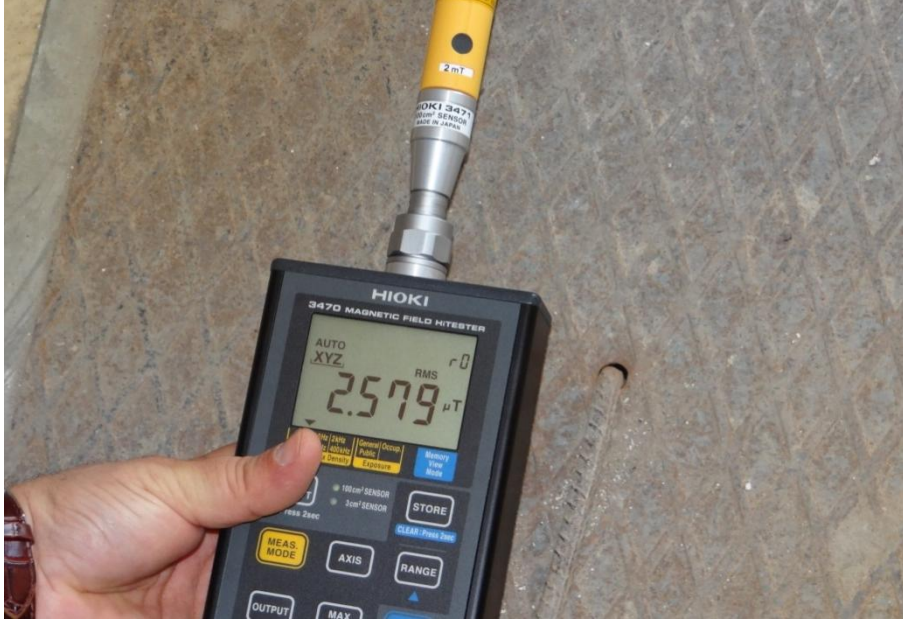
Şekil 5.4. Antalya ili Serik İlçesi Şehir 1 Fideri AG Kablo Kanalında Ekranlı Ölçüm
