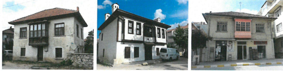
Şekil 4.14. İlçe merkezinde yer alan geleneksel konutlardan görünümeler
