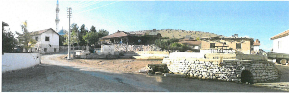
Şekil 4.44. Avdan Mahallesi yerleşim merkezi (cami-çeşme-su sarnıcı) (Orijinal 2016)
