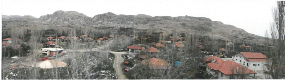
Şekil 4.49. Kozağacı Mahallesi güneybatı görünümü (Orijinal 2016)
