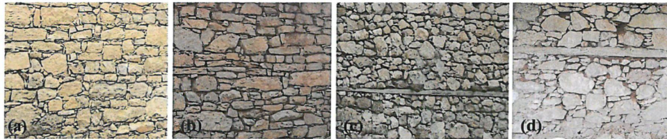
Şekil 4.133. Ulucak (a), Beğiş Susuzu (b), Kozağacı (c) ve Osmankalfalar (d) Yerleşimlerdeki konutlardan taş duvar örgülerinden örnekler (Orişinal 2016)
