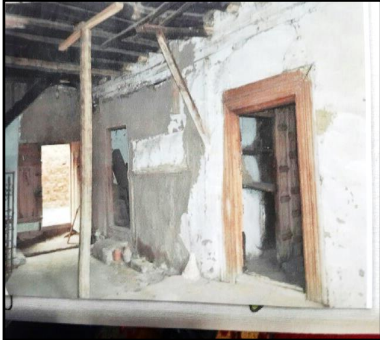
Fotoğraf- 15 Restorasyon Öncesi Giriş Kat
