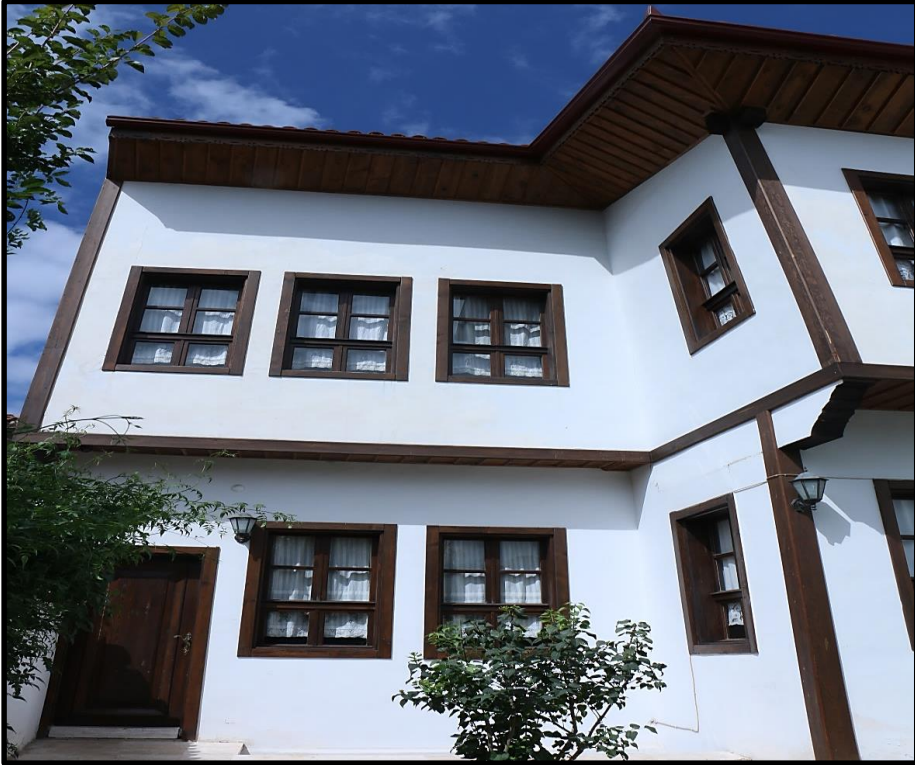
Resim- 9 Restorasyon sonrası arka cephe.
