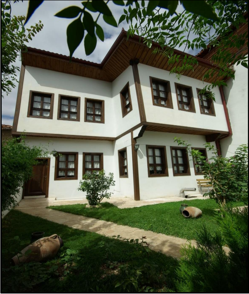
Resim- 10 Bahe ve arka cephe.
