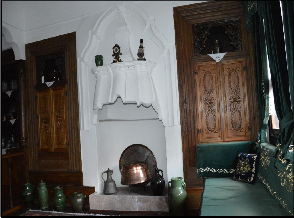
Resim- 29 Giriş kat( Z02 numaralı) alçı sundurmalı ocak ve nişler.
