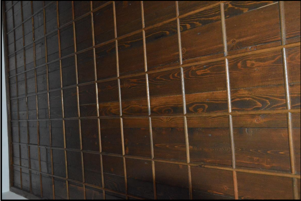
Resim- 44 Üst kat (102 numaralı oda) çitekâri tavan.
