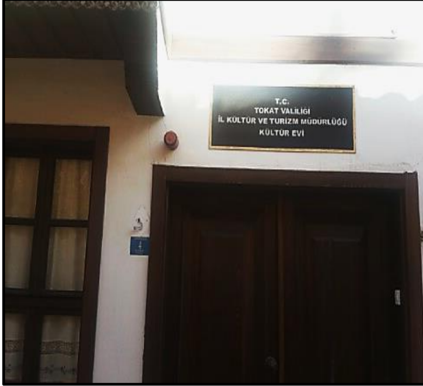
Resim- 6 Restorasyon sonrası kapı girişi.
