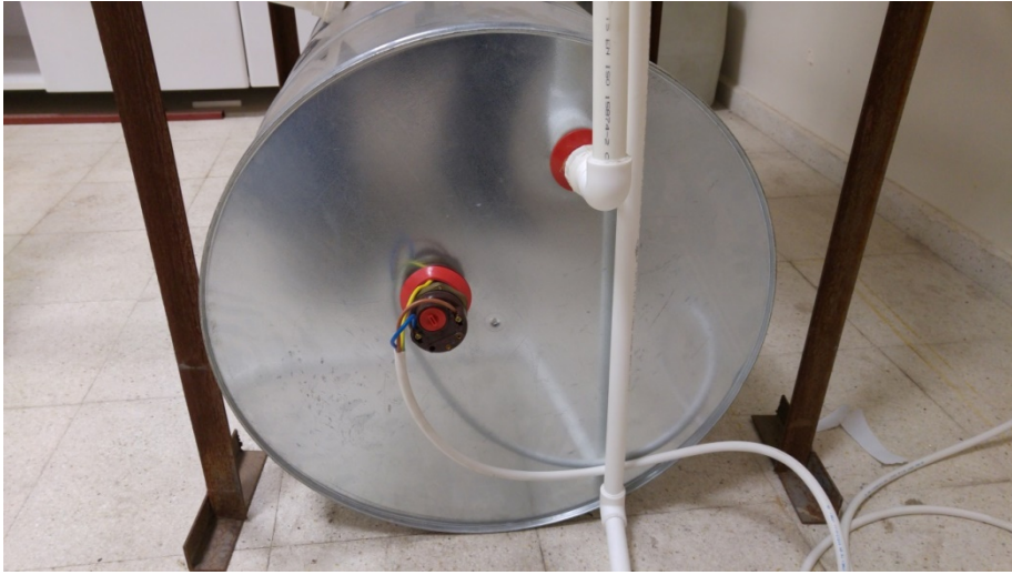
Şekil 3.6. Sıcak su deposu ısıtıcısı ve soğuk su dönüş girişi
