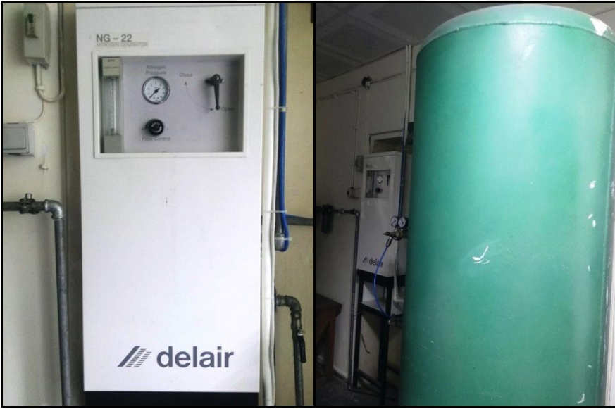
Şekil 3.10. İkinci deneme yılında kullanılan KA sisteminin azot jeneratörü ve azot tankının genel görünümü
