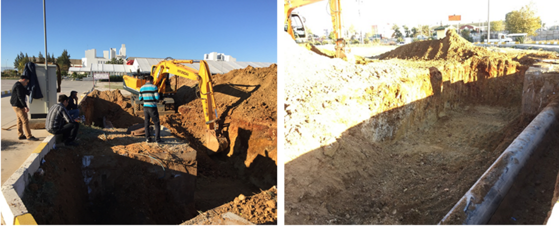
Şekil 3.17. PAT sisteminin kurulacağı by-pass hattı için kazı çalışması, ana hat borusunun açığa çıkarılması (Muhammetoğlu vd 2016)
