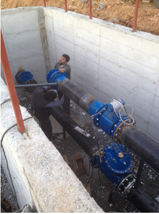
Şekil 3.20. By-pass rögarı içerisinde PAT sisteminin kurulumu (Muhammetoğlu vd 2016).
