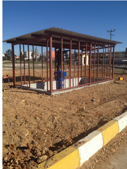
Şekil 3.21. By-pass rögarı üzerine kabin yapılması (Muhammetoğlu vd 2016)
