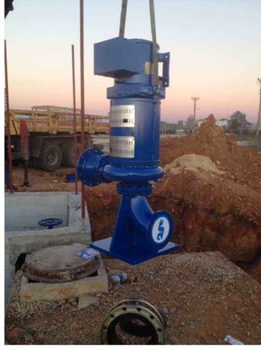
Şekil 3.20. By-pass rögarı içerisinde PAT sisteminin kurulumu (Muhammetoğlu vd 2016).
