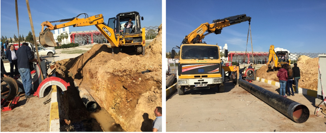
Şekil 3.18. PAT sisteminin bağlanacağı ana hat borusunun değiştirilmesi (Muhammetoğlu vd 2016)
