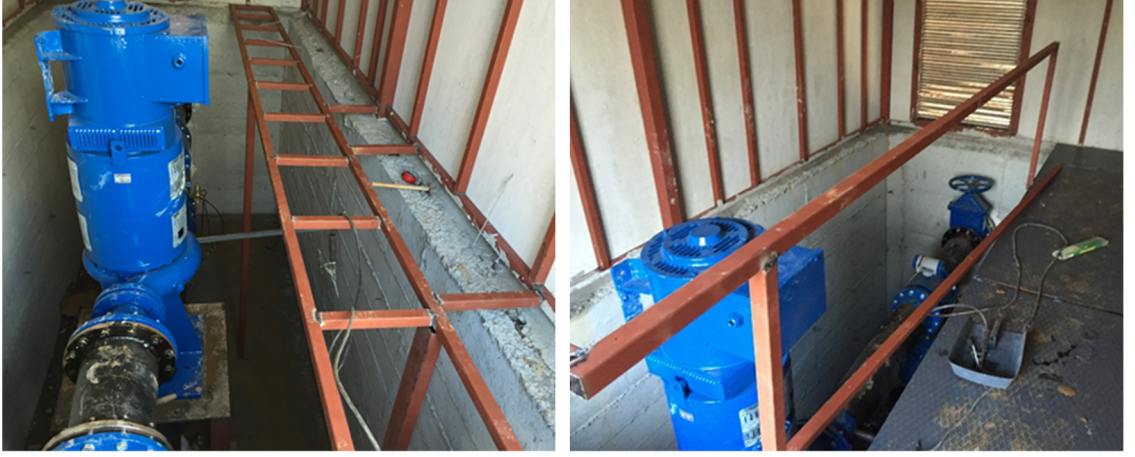
Şekil 3.22. By-pass rögarı içerisinde yürüme yolu ve merdiven yapılması (Muhammetođlu vd 2016)
