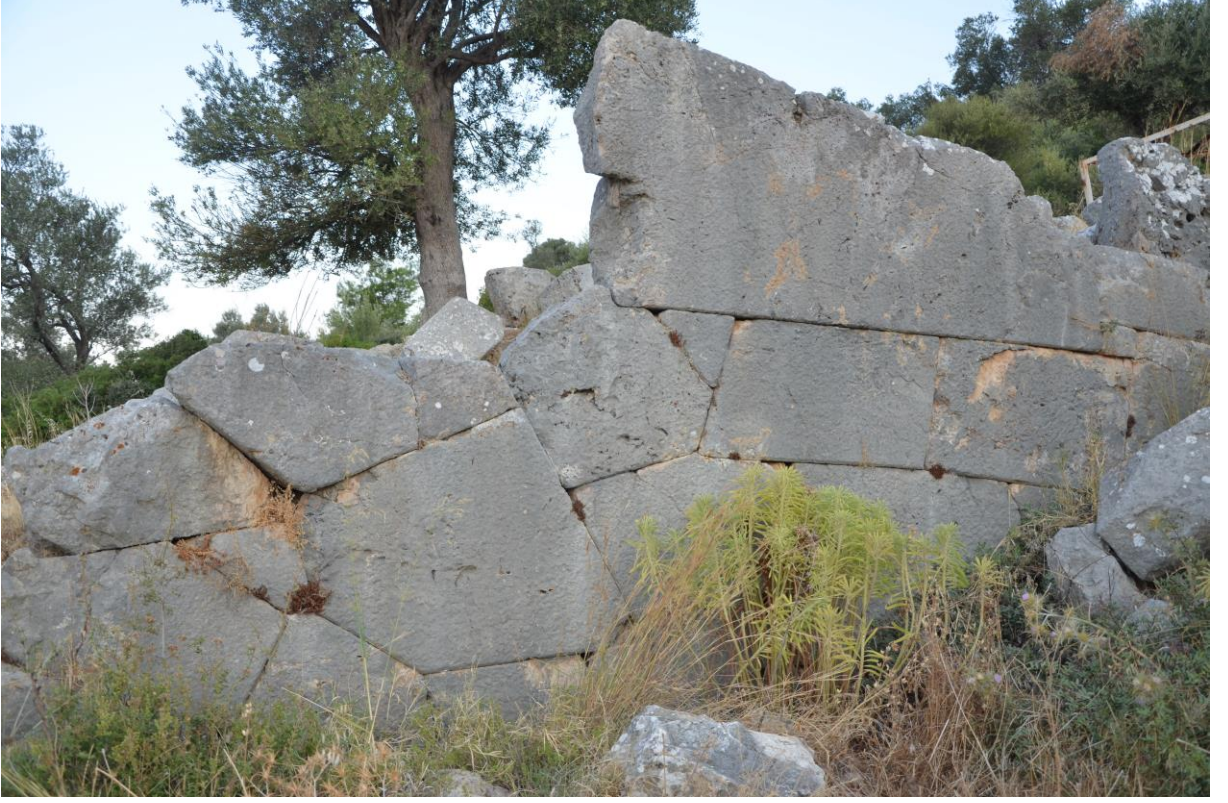
a- Lykia Yapısı, Doğu Dış, Polygonal
