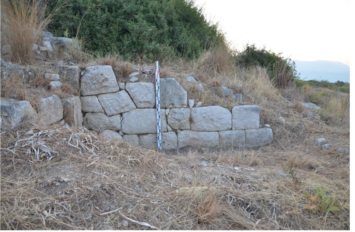
a- Kuzey – Güney Yönlü Duvar
