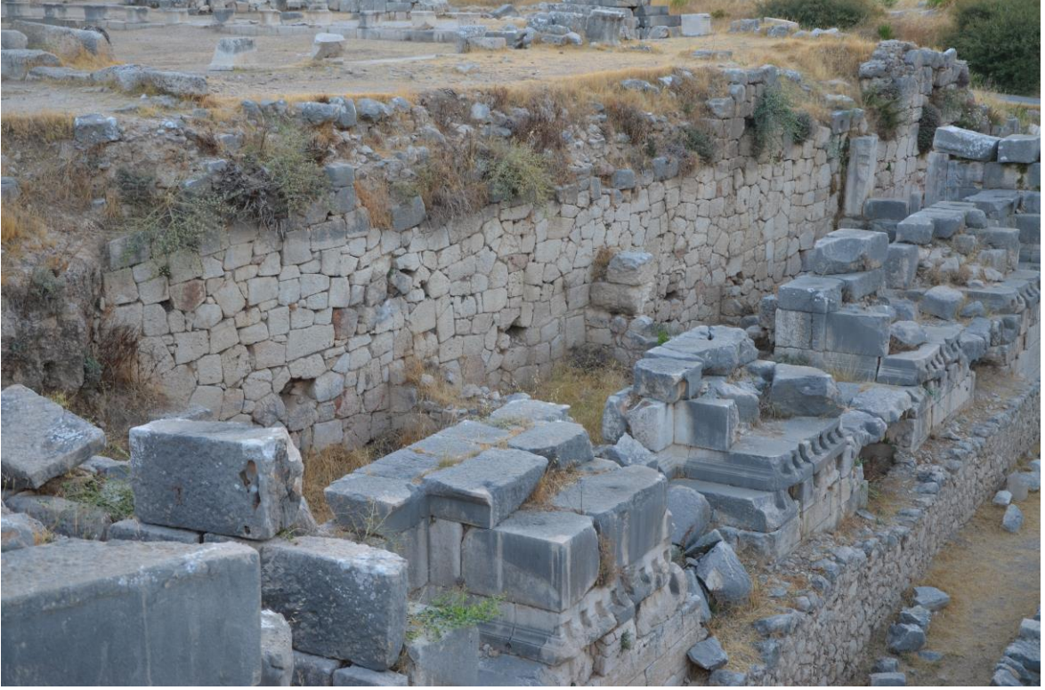
a- Tiyatro Agora Arasındaki İsitnat Duvarı
