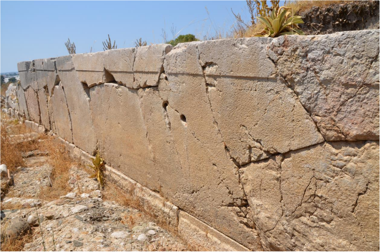
b- Güneydoğu Sektör, Doğu Duvar
