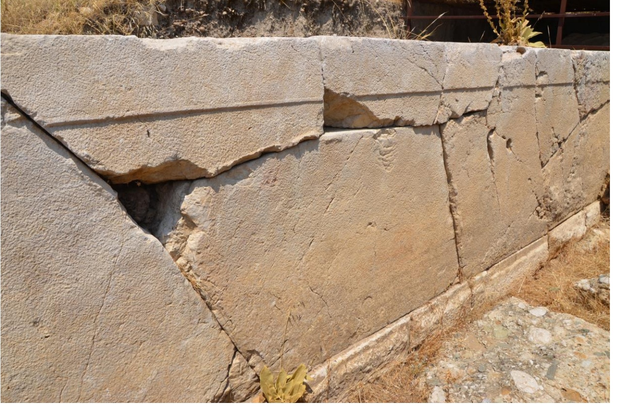
a- Güneydoğu Sektör, Doğu Duvar
