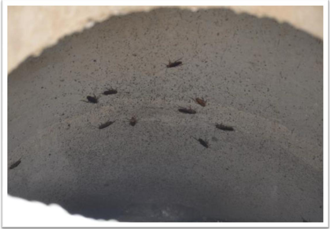
Şekil 3.3. Kablo kanalı rögarındaki P. americana bireyleri
