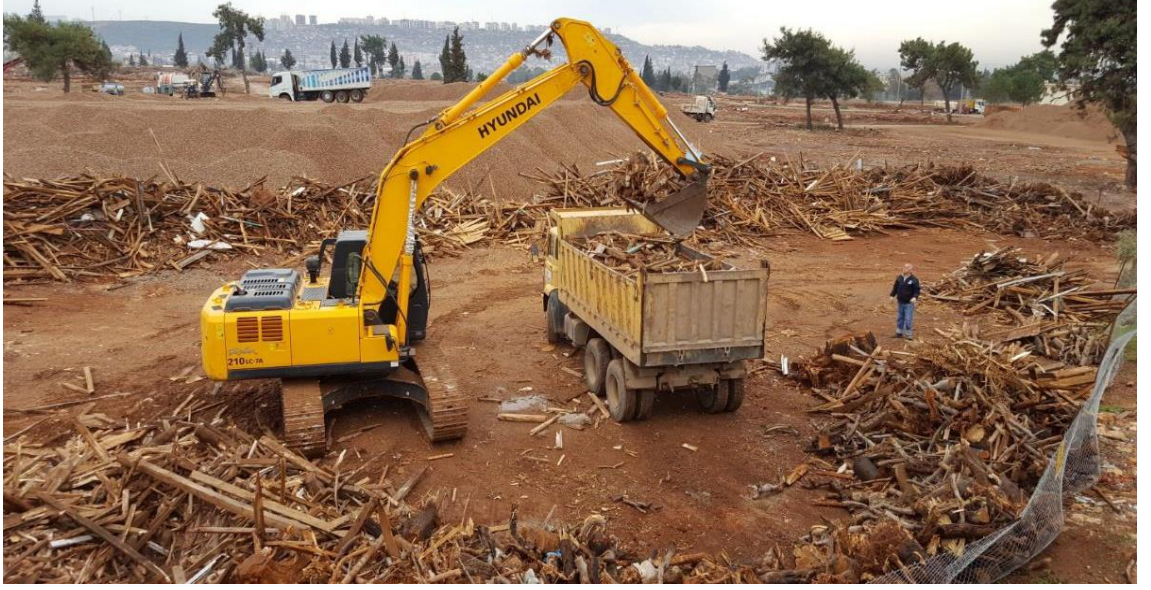
Şekil 4. 49. Ahşap malzeme stoku
