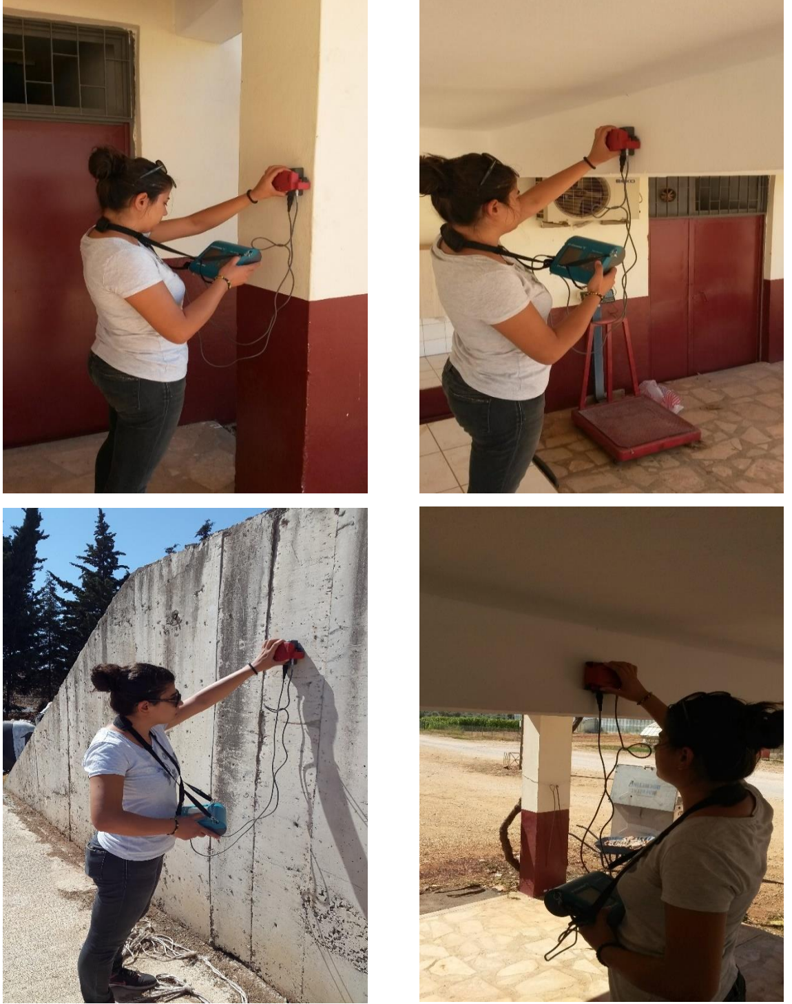
Şekil 4.3. Donatı tespit cihazının kolona, kirişte ve duvarda yapılan tarama uygulanması
