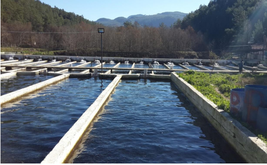
Şekil 2.3. Balık örneklerinin temin edildiği ticari alabalık işletmelerinden beton havuz
