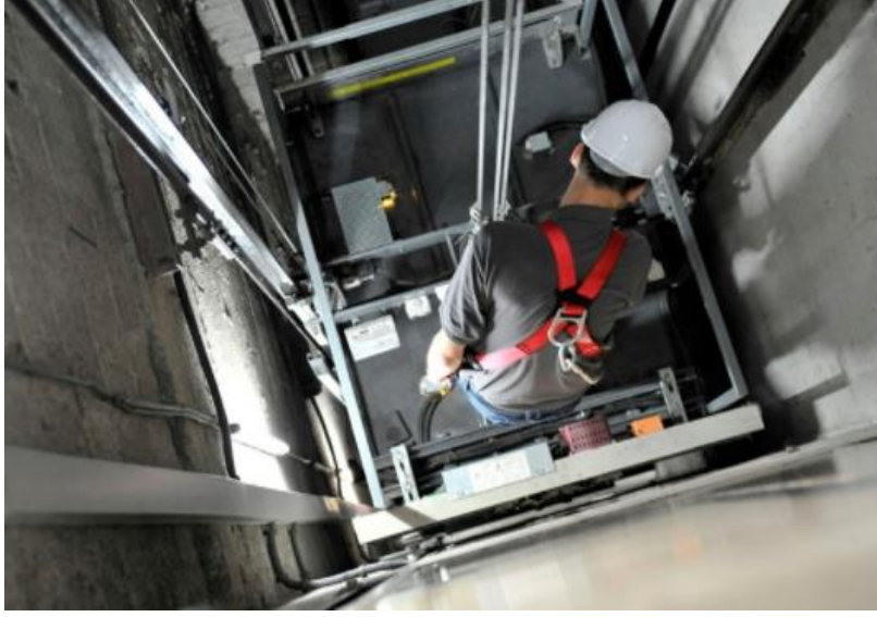
Şekil 6.66. Asansör montaj ve bakımında emniyet koşulları
