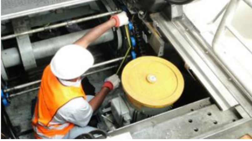
Şekil 2.67. Yürüyen merdiven ve bantlarda bakım onarım işlemi
