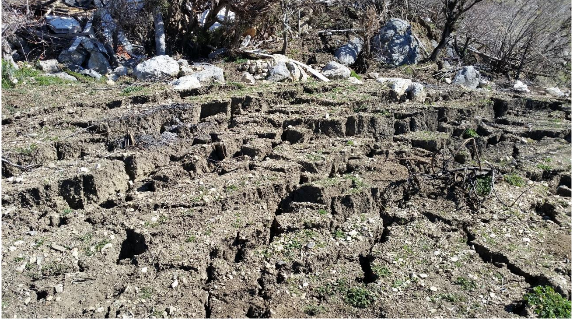
Şekil 4.23. Meydana gelen heyelana ait tahribat görüntüleri (5 nolu heyelan noktası)
