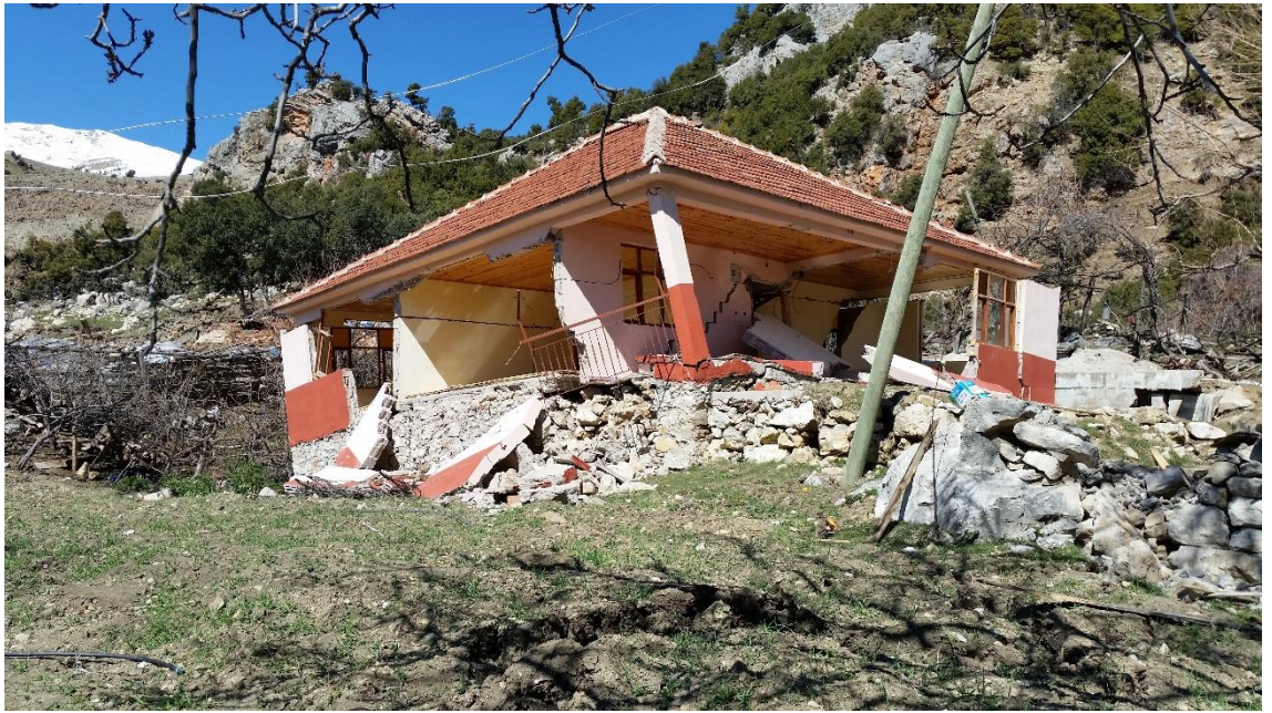
Şekil 4.20. Meydana gelen heyelana ait tahribat görüntüleri (2 nolu heyelan noktası)
