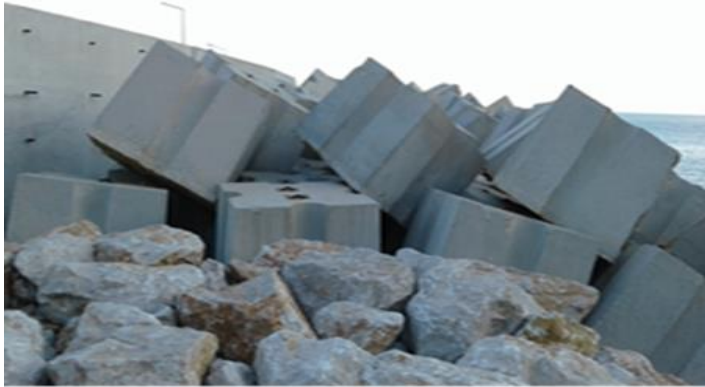
Şekil 3.6. Antifer bloklı dalgakıran inşası
