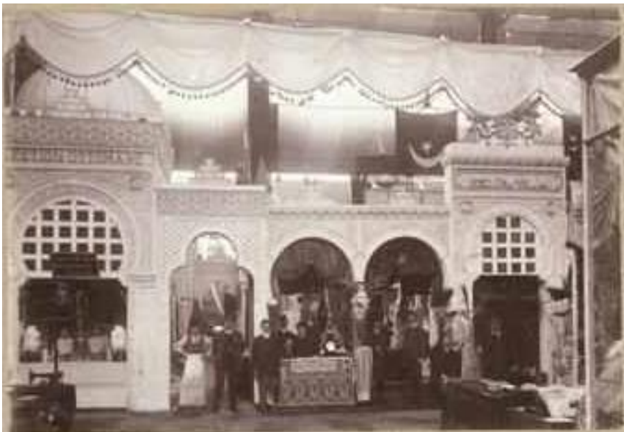
Görsel 1.78 1905 Uluslararası Liège Sergisi Osmanlı Pavyonu Cephesi
