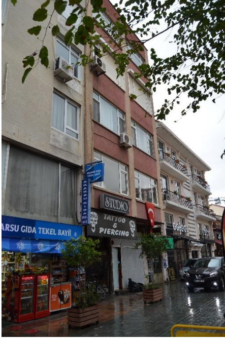
Şekil 4.13. Betonarme bir yapı ve zemin kattaki işletme tabelalarının tarihi çevreyle uyumsuz olmasına bir örnek (Orjinal 2018)
