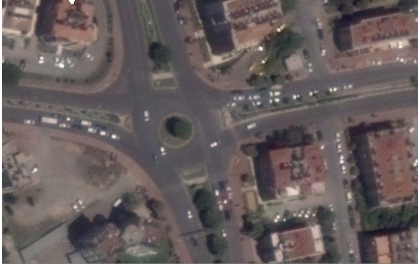
Şekil 3.11. Burhanettin Onat Caddesi-Metin Kasapoğlu Caddesi Kavşağı (Sampi Kavşağı) 2016 Yılına Ait Durum ve Çalışma Alanının Genel Görünümü
