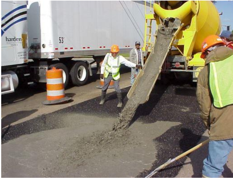
Şekil 2.2. Yarı rijit kaplamada kullanılan akışkan harç (Randy 2007)
