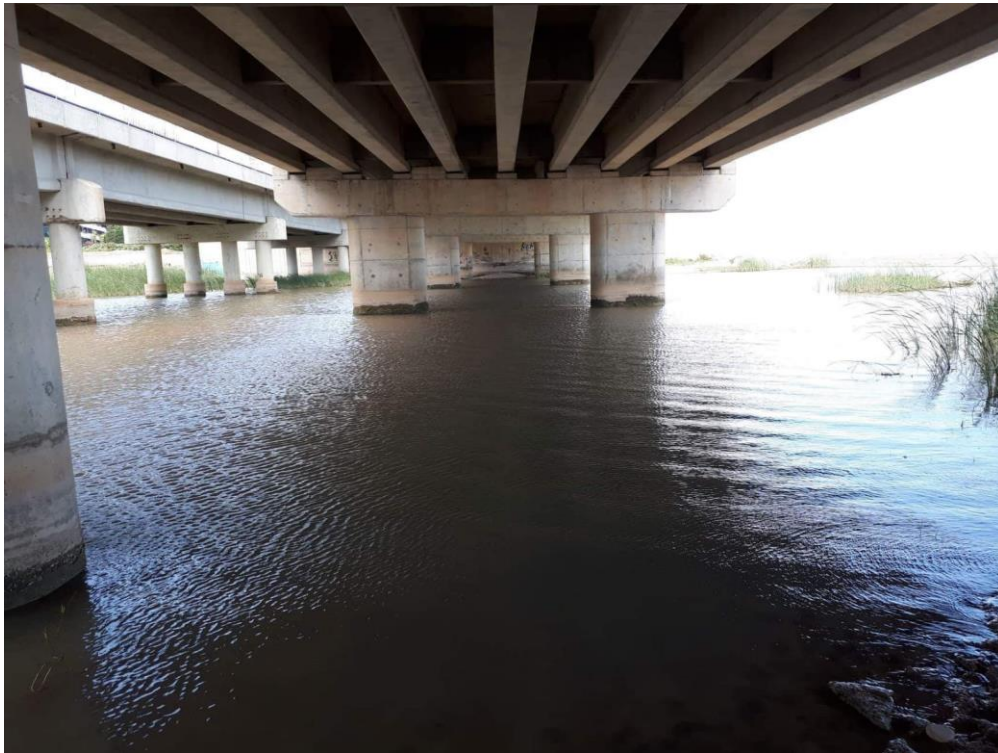
Şekil 3.3. Köprü ana elemanlarına ait bir görünüş
