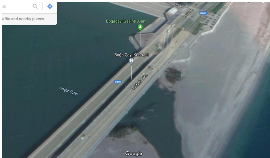
Şekil 3.1. Boğaçay köprüsünün uydu görüntüsü
