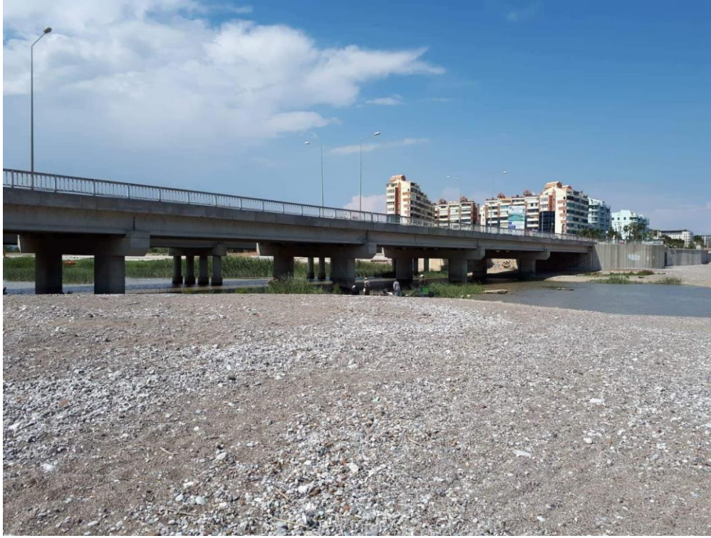
Şekil 3.2. Köprü genel görünüşü
