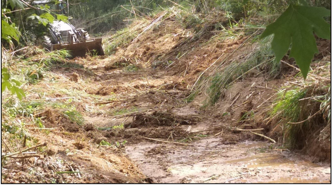
Şekil 3.5. Karaman Duraliler Sulama Birliği'nde bakım-onarım faaliyetleri
