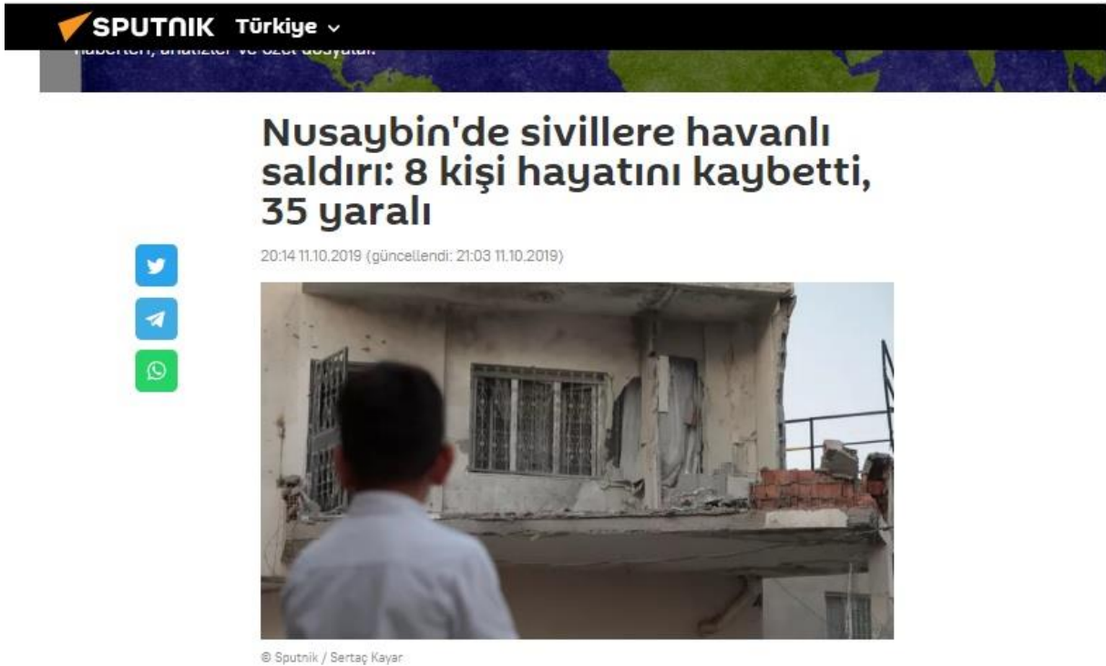
Görsel 4.7 Sputnik News, Yıkılan Şehir Binası
