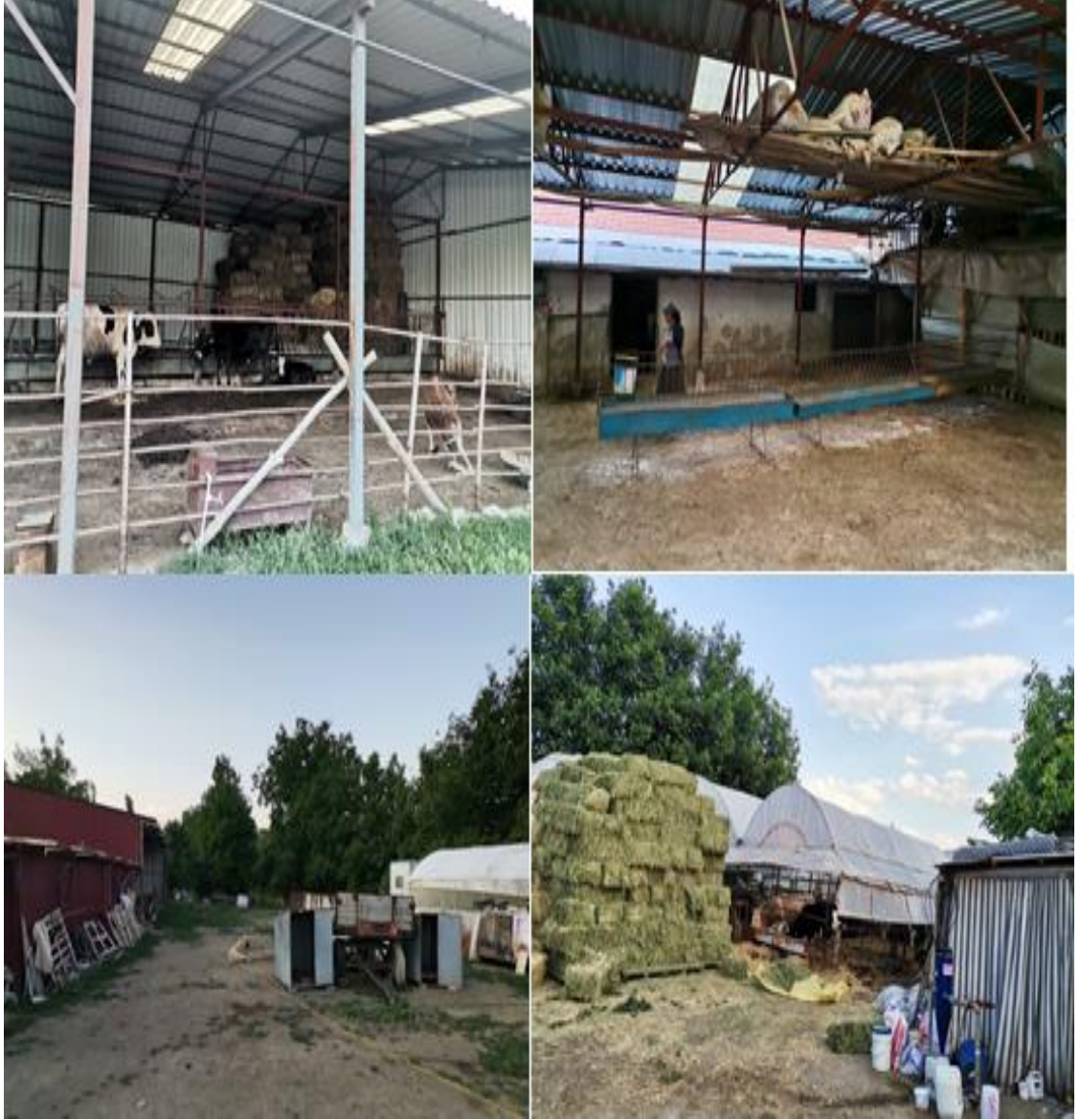
Şekil 7.1. Kızılcadağ/ Mamatlar Köyünde Bir Süt İşletmesi
